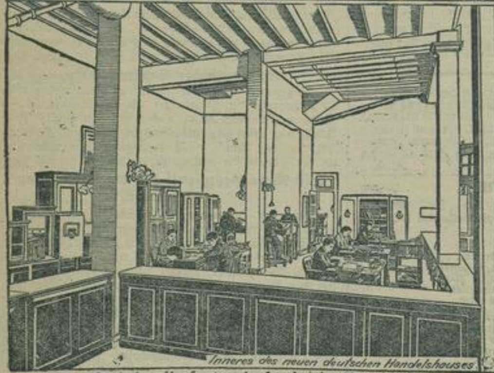
Neubau eines deutschen Handelshauses in Buenos Aires während des Krieges
