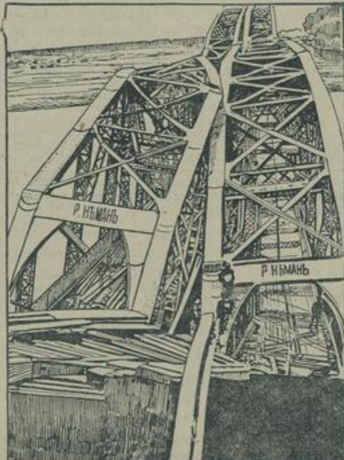
Die von den Russen bei ihrem Rückzug zerstörte Eisenbahnbrücke bei Mosty.
