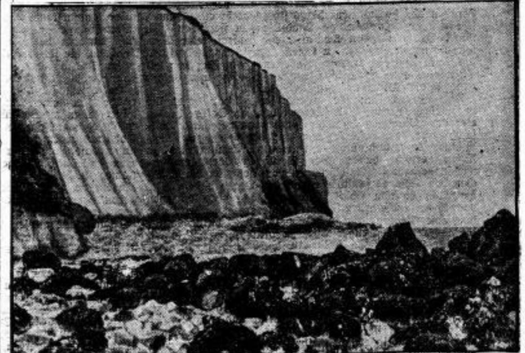
An der englischen Küste unweit Dover löste sich die Steilwand in einer Breite von 45 Metern und einer Tiefe von 12 Metern und stürzte ins Meer.
