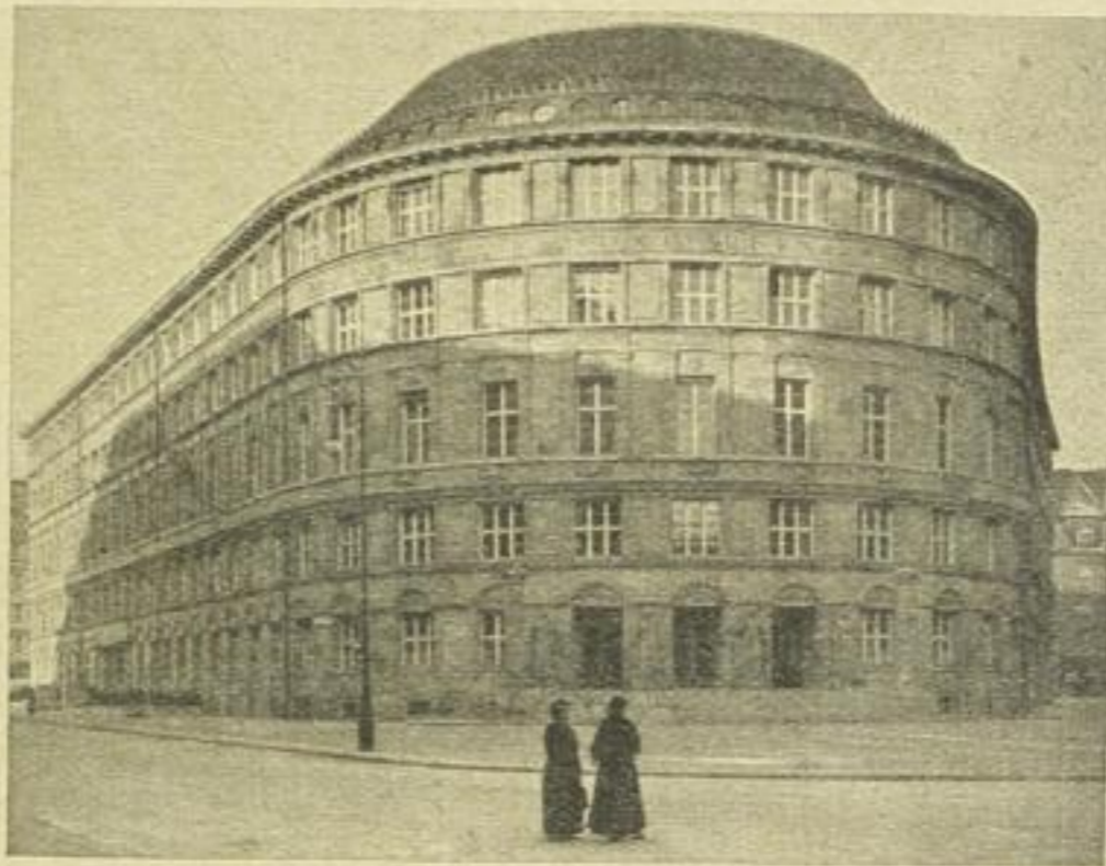
Abb. 123. Verwaltungsgebäude des „Nordstern“ in Berlin-Schöneberg. Arch.: Paul Mebes.
