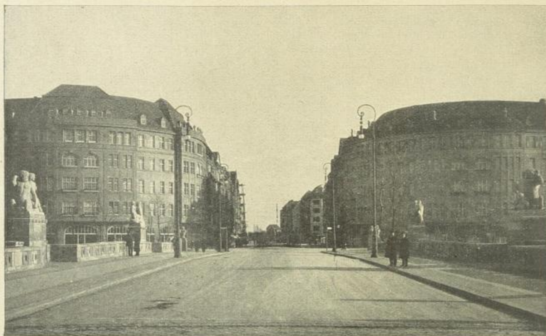
Abb. 83. Straßeneingang in Berlin-Schöneberg (Ecke Innsbruckerstraße und Stadtpark). Arch.: Paul Wolf.
