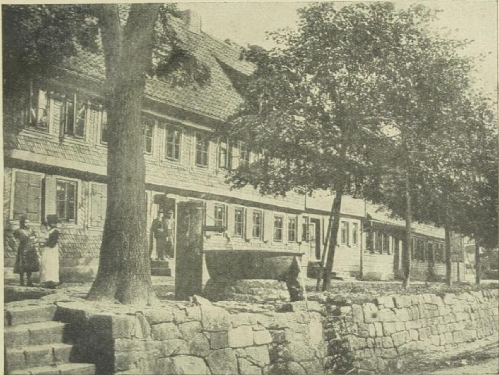
Abb. 37. „Untere Sorge“ in Clausthal i. H.
