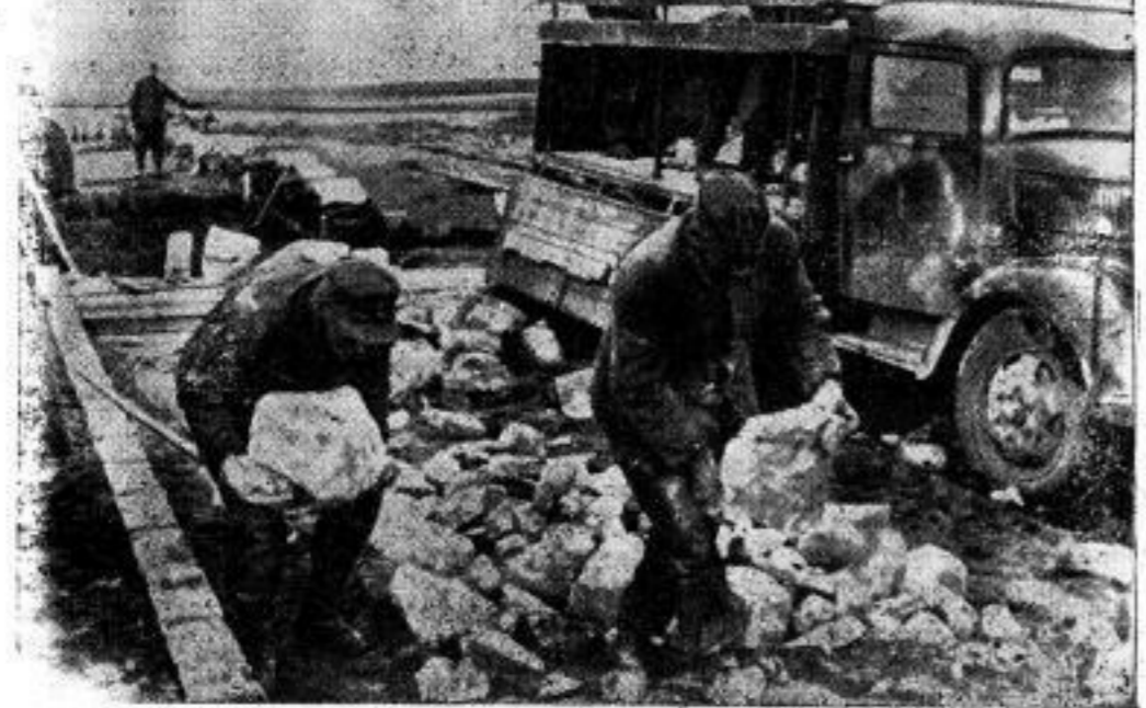
Eine neue Straße entsteht. In mühevoller Arbeit legt hier die Mannschafft eines Bau-Pionier-Bataillons eine neue Nachschubstraße in einem Abschnitt der Ostfront an. (W.-Aufnahme: Kriegsberichterst. Ruthert, Sch., 3.)
