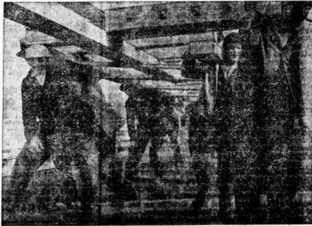
Ein großer Binder wird aufgerichtet.
