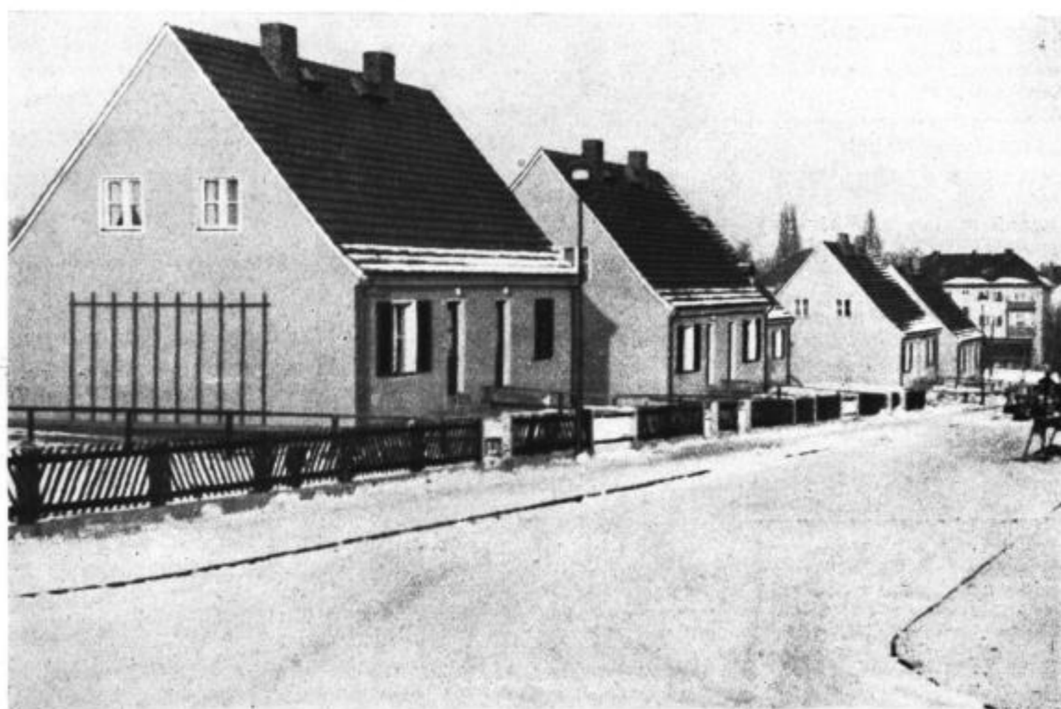
Am Stadtrand im Süden Dresdens bei der Teplitzer Straße sind im vergangenen Jahre die Felder verschwunden. Neue Straßennamen tauchten auf, denn trotz der Kriegszeit ist dort ein neues Wohnviertel entstanden. 110 Reichsheimstätten hat die Gafab (Gemeinnützige Aktiengesellschaft für Angestellten-Heimstätten) errichtet. „Kalerwinkel“ haben die Siedler dieses neue Wohnviertel genannt, weil es von der Geystraße (Leonhard Gey, † 1893), der Kerstingstraße (Friedrich Georg Kersting, † 1847) und der Gußmannstraße (Prof. Gußmann, † 1926) durchzogen bzw. begrenzt wird. Aufn. Gerhard Lehmann
