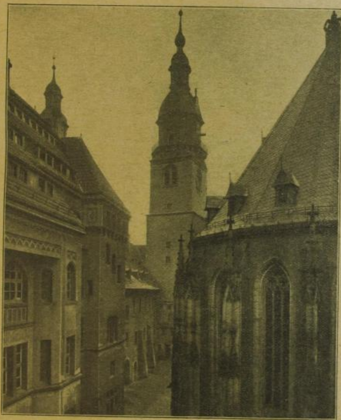
Rathausplatz mit Blick auf den Jakobikirchturm und das architektonisch wertvolle Chor der Jakobikirche
