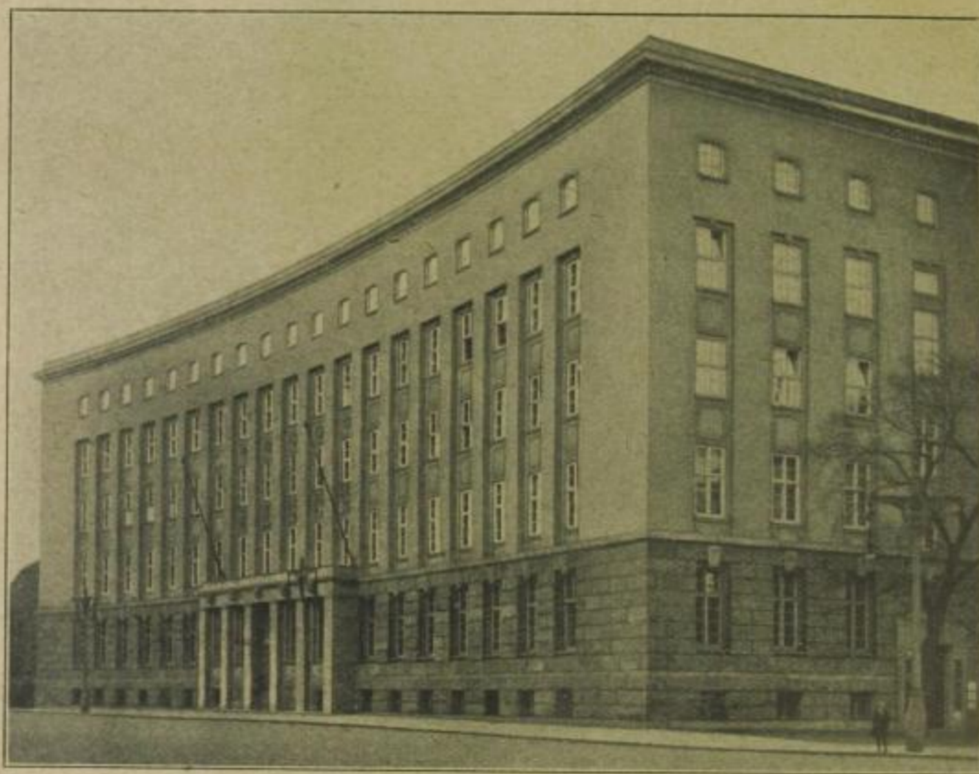
Palastartiges Gebäude der Deutschen Bank, am Falkeplatz (Architekt: Erich Dörfte, Chemnitz, 1925.)
