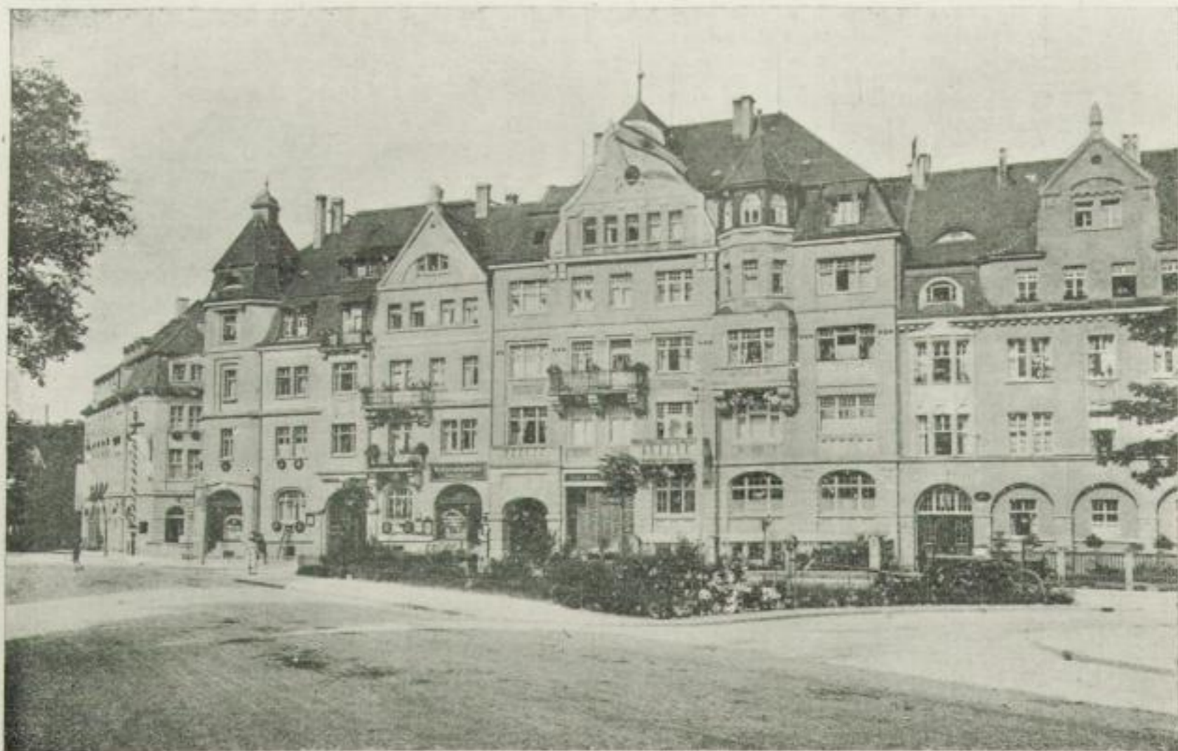
Eingang zur Schillerstraße.
