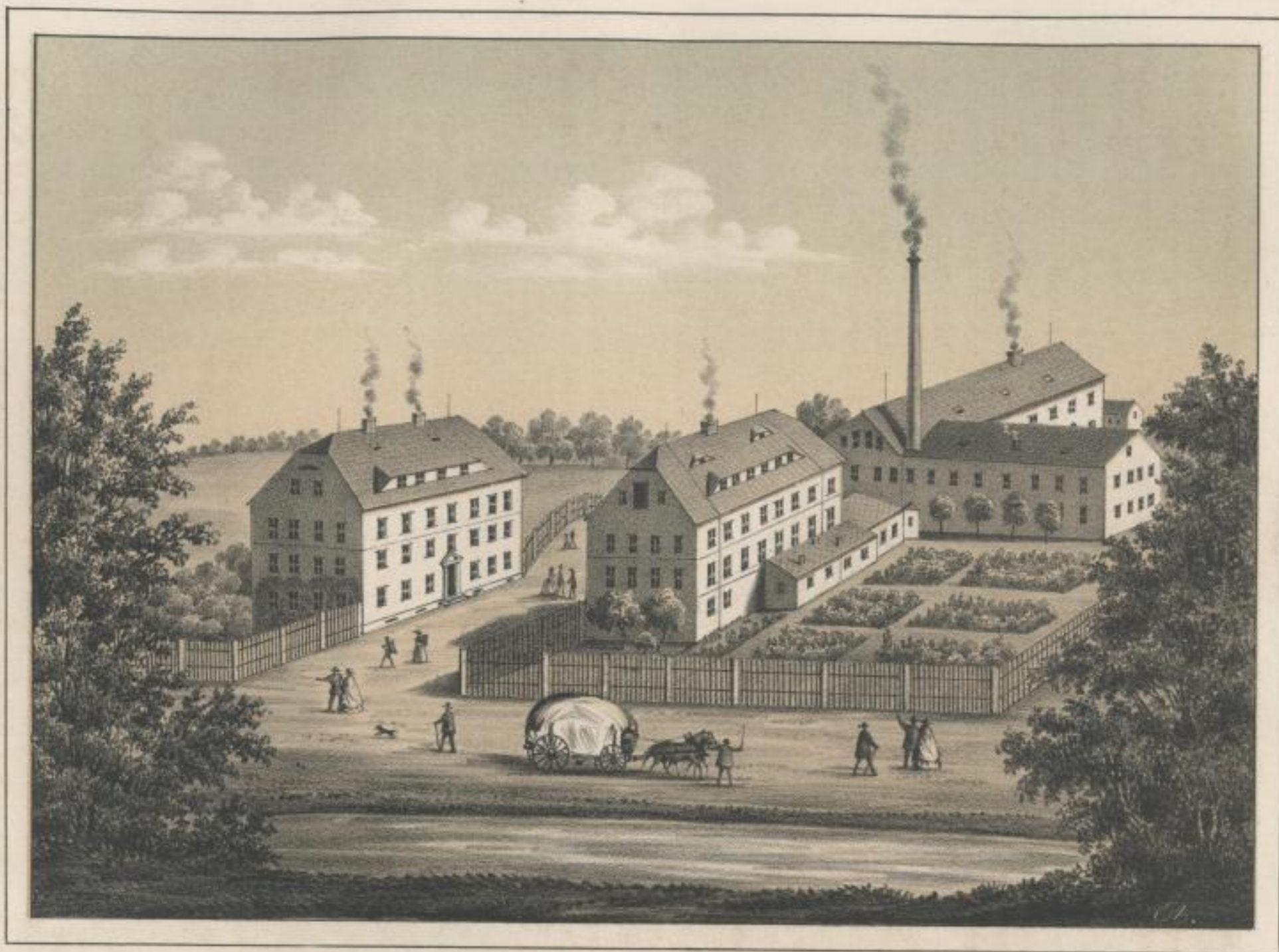
Band und Hosenträgerfabrik von Johann Gottfried Schöne in Grotz-Röhrsdorf.
