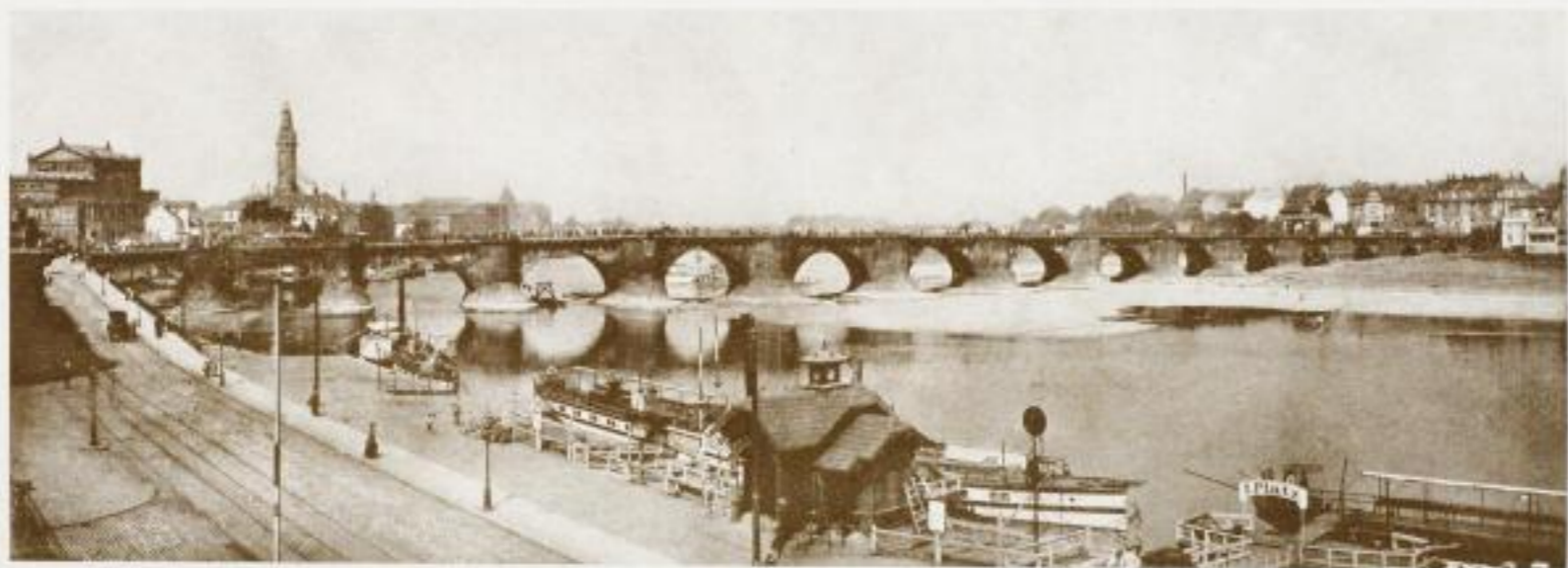
1. Gesamtbild der alten Augustusbrücke vor dem Abbruch.
