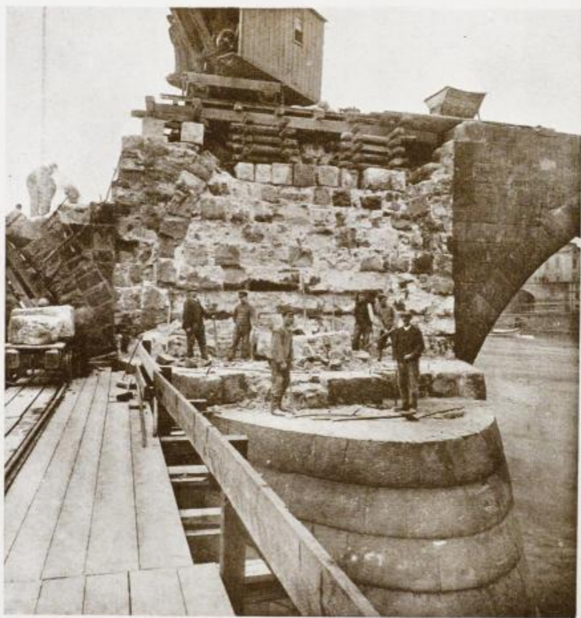
48. Hinterkopf des Pfeilers 12 mit Verspannungsbogen in der Stirnwand.
