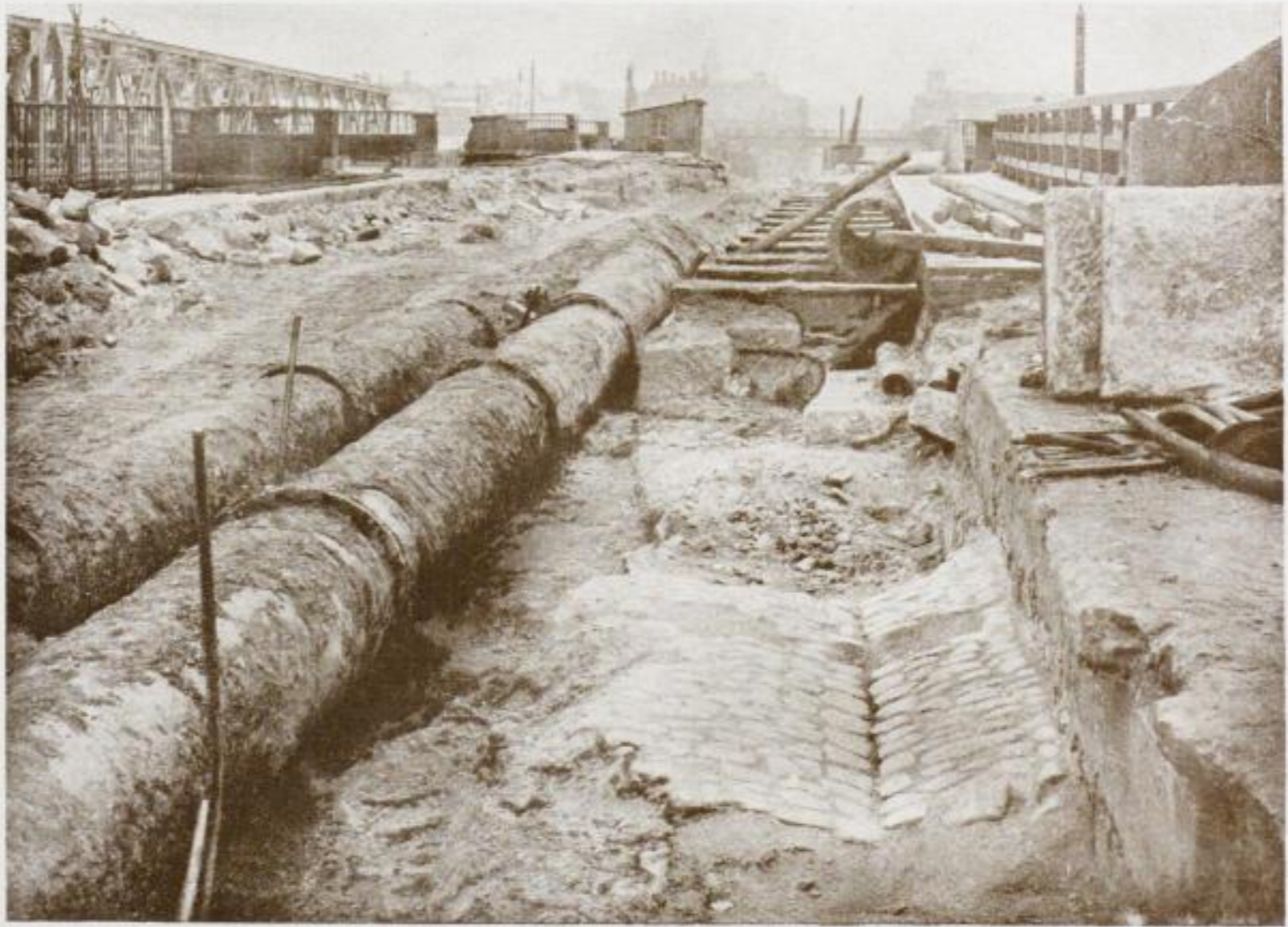
50. Freigelegtes altes Brückenpflaster auf Pfeiler 10.
