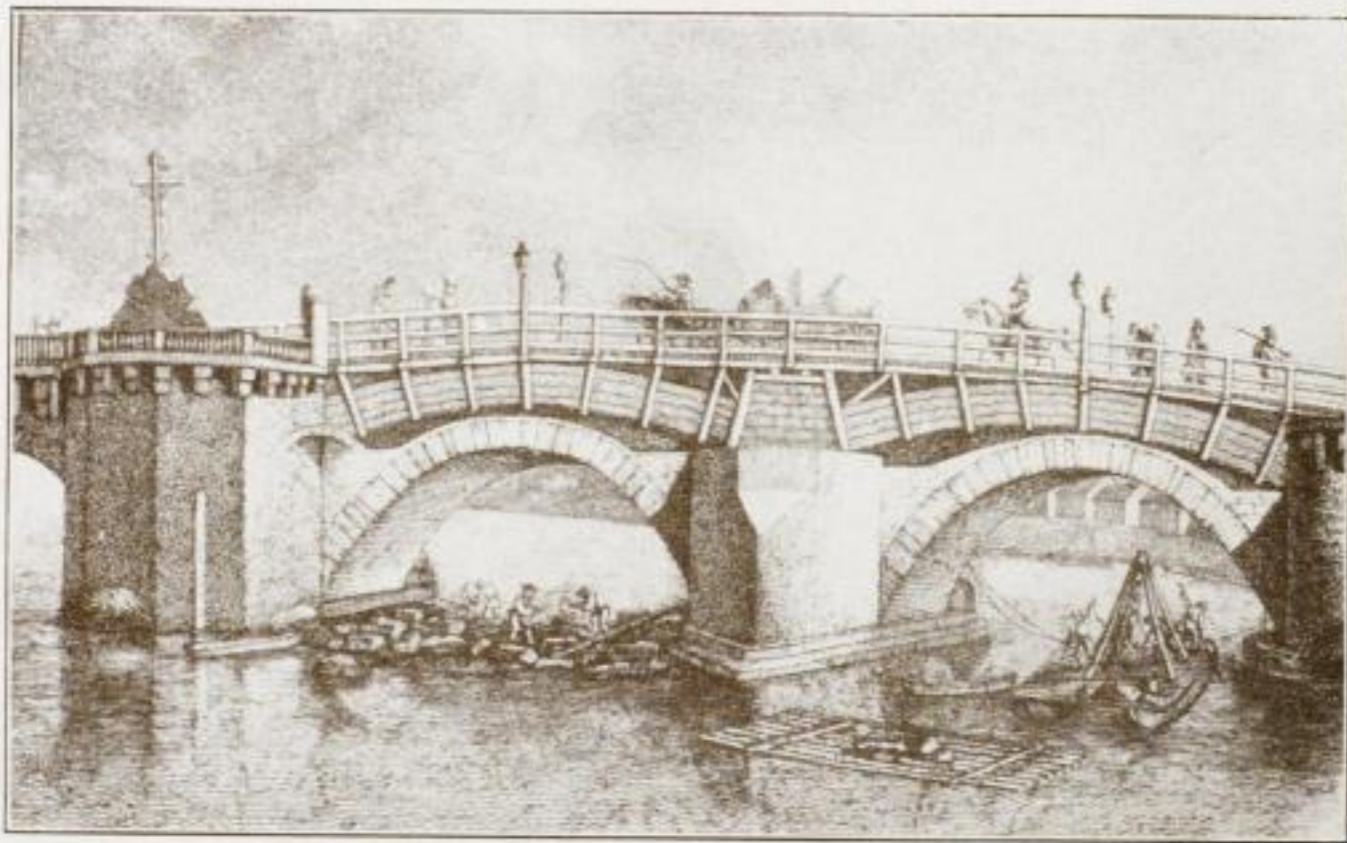
72. Wiederherstellung der 1813 gesprengten Brückenbogen. (Aus Förster, Augustusbrücke.)
