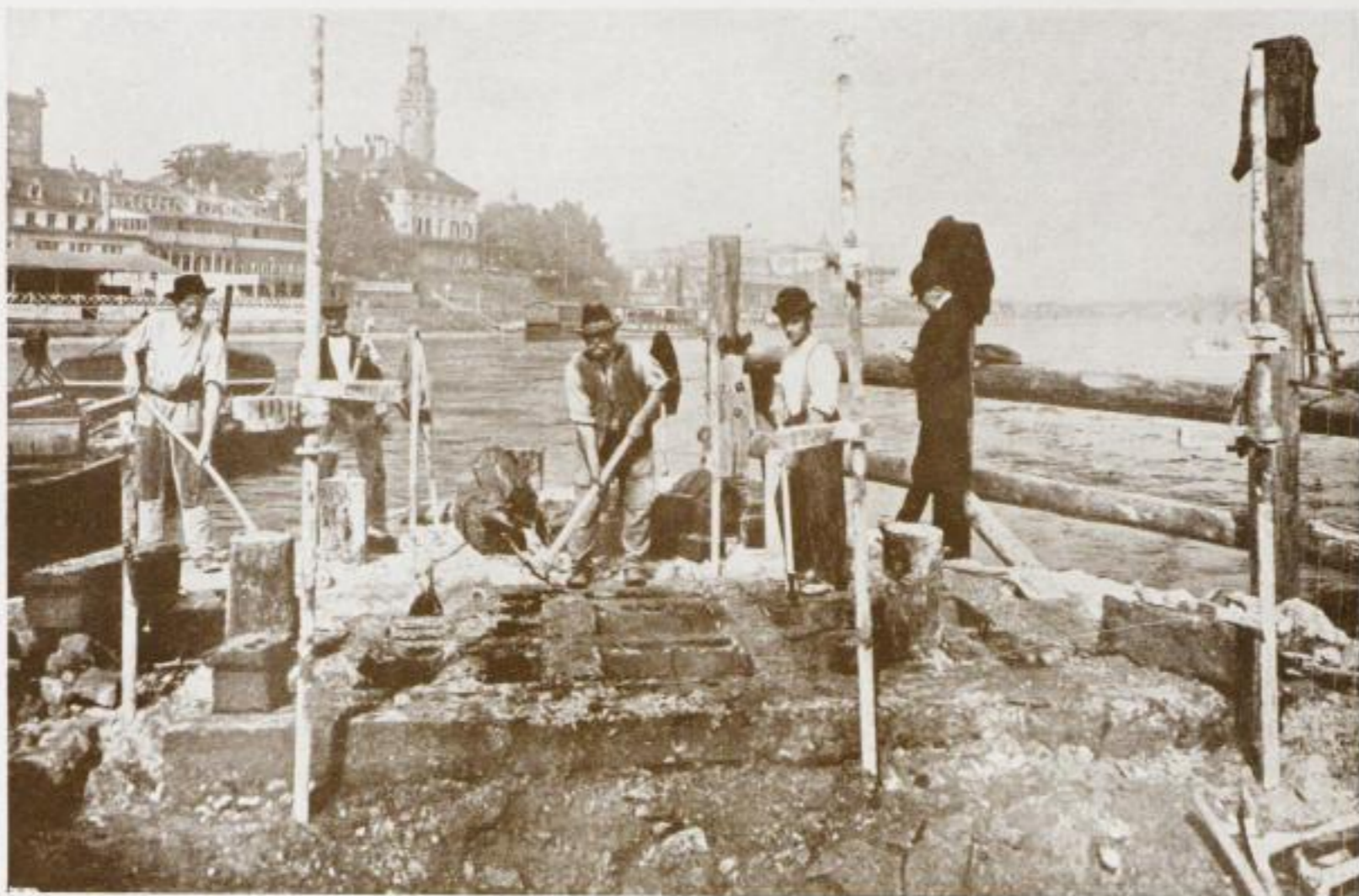
75. Kofst und eiserne Verankerung des Pfeilers 11.
