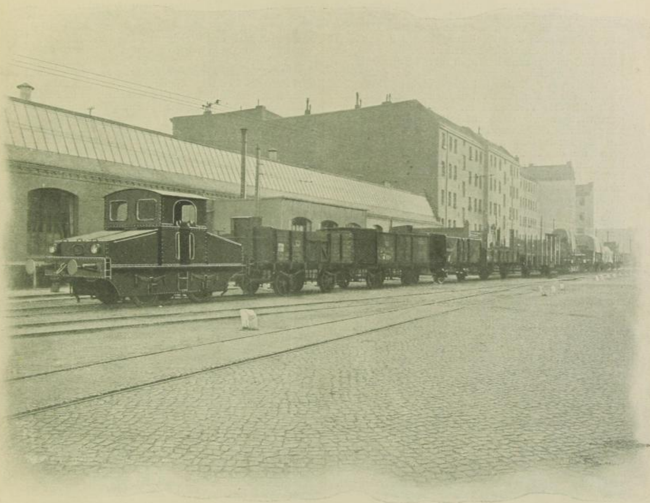
Akkumulatorenlokomotive für die Zuckerfabrik Noerten (Prov. Hannover).
