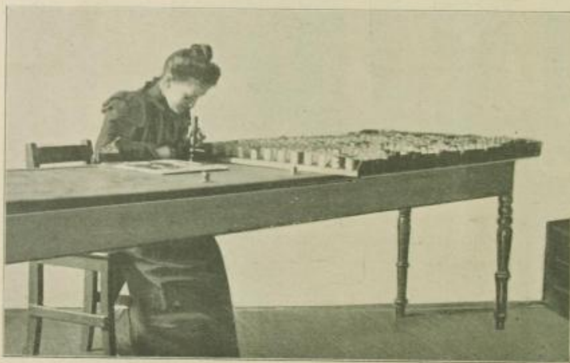
Mikroskopische Kontrolle der Federplättchen.
