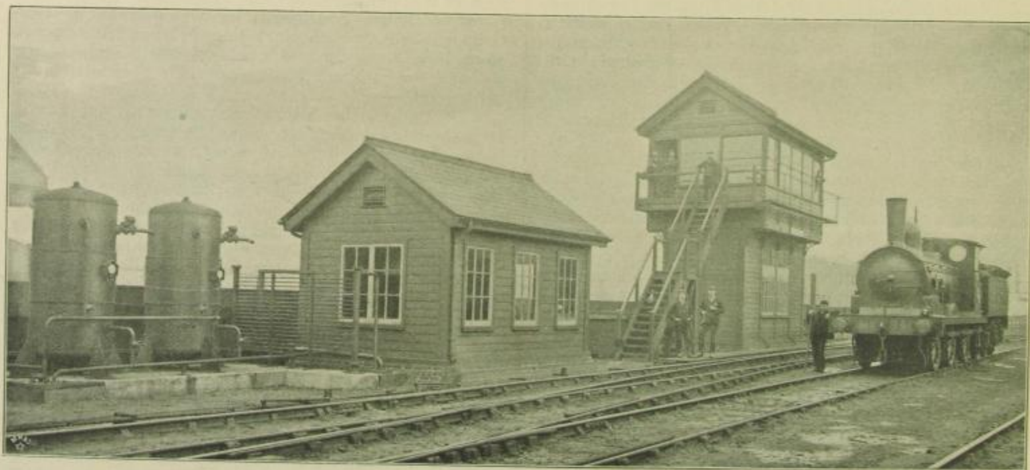
Gesamtansicht des Stellwerkes.
