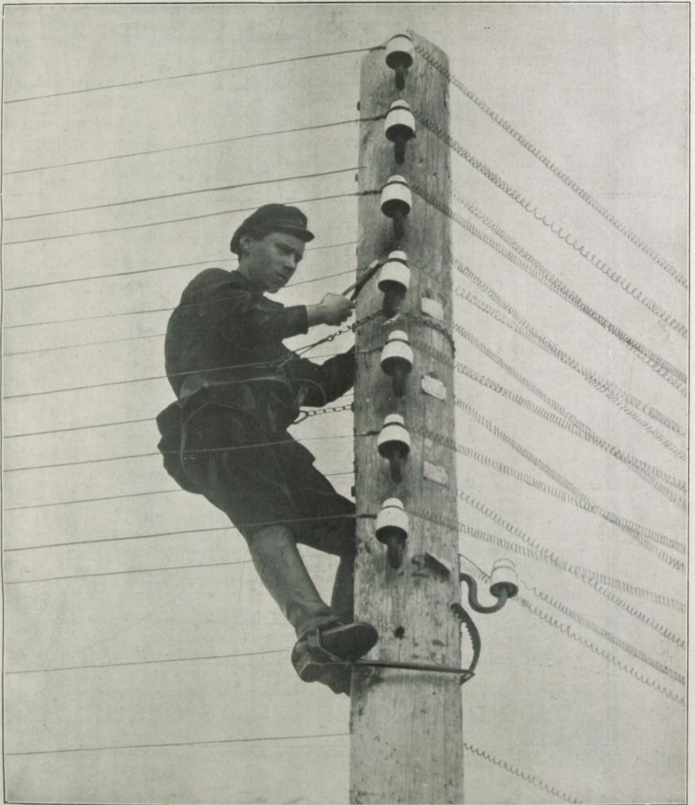
Russischer Telegraf-Arbeiter beim Bau einer Oberleitung
