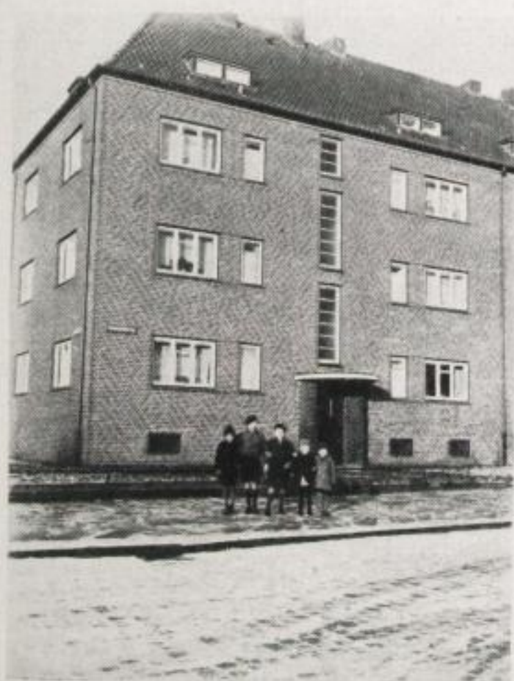
Bau ist bezogen
