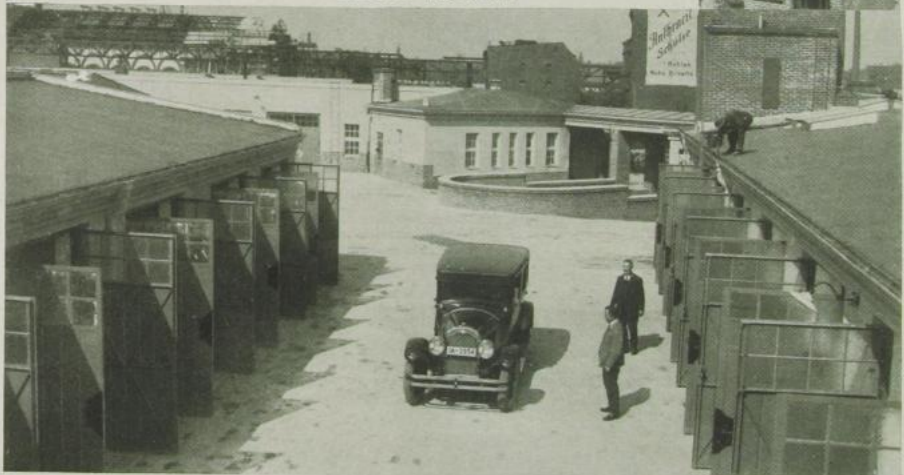
Der Berliner Schebera-Großgaragenpalast Innenansicht und Einfahrt
