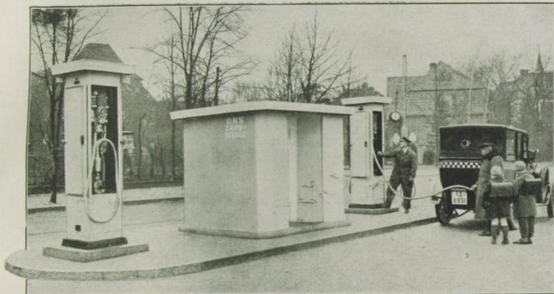
Zapfstelle der Reichskraftsprit G. m. b. H. (Monopolin) mit zwei getrennten Zapfstellen und in der Mitte ein Häuschen als Werk- und Aufenthaltsraum für die Bedienungsmannschaften
