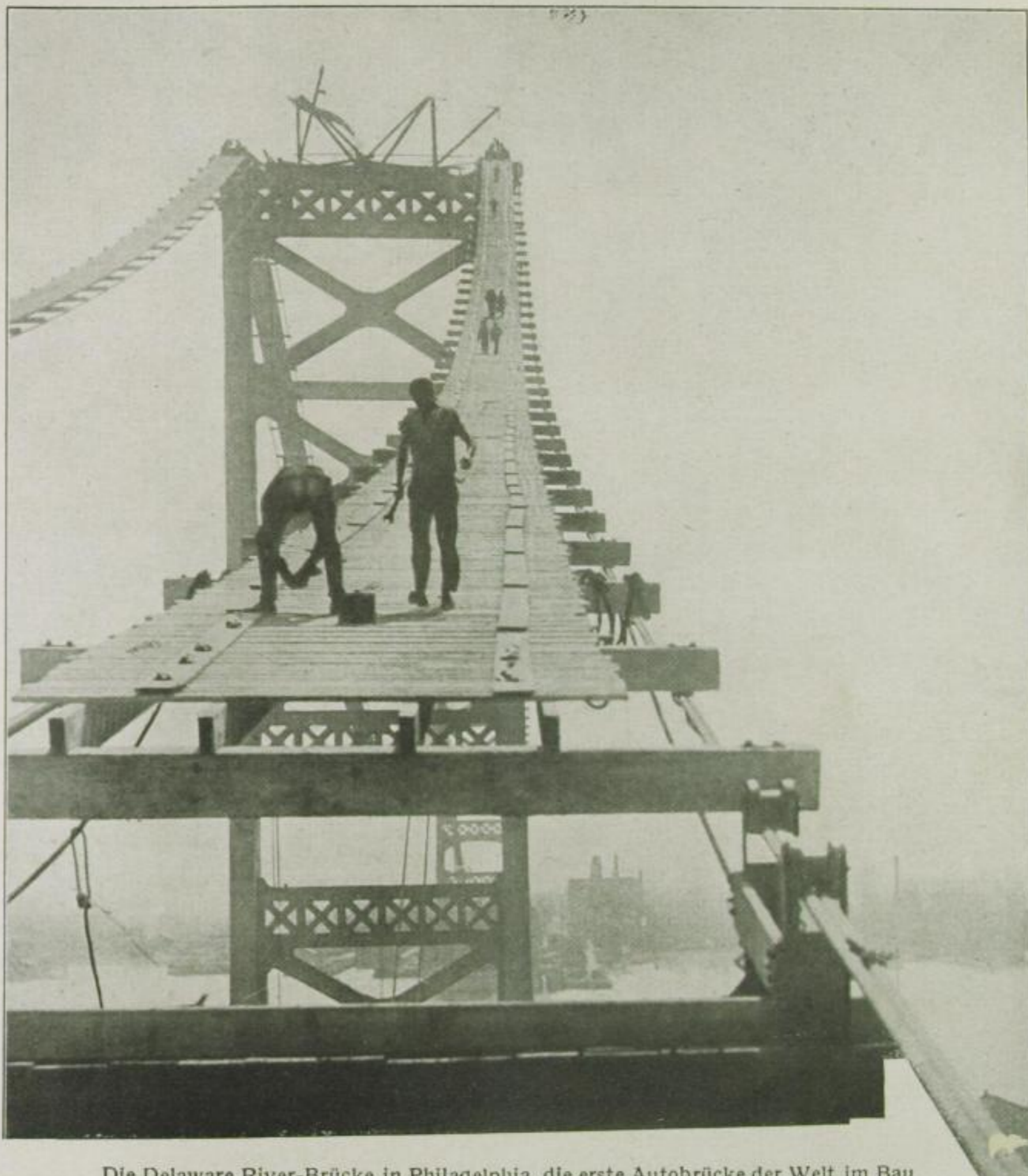
Die Delaware River-Brücke in Philadelphia, die erste Autobrücke der Welt im Bau
