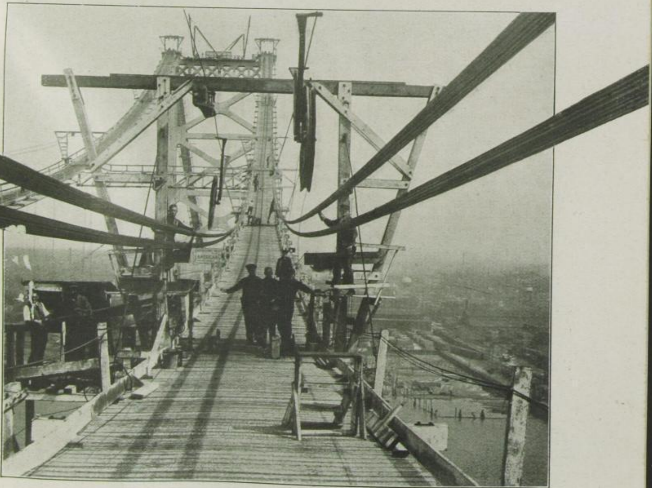
Der Bau der riesigen Brücke in fortgeschrittenem Stadium
