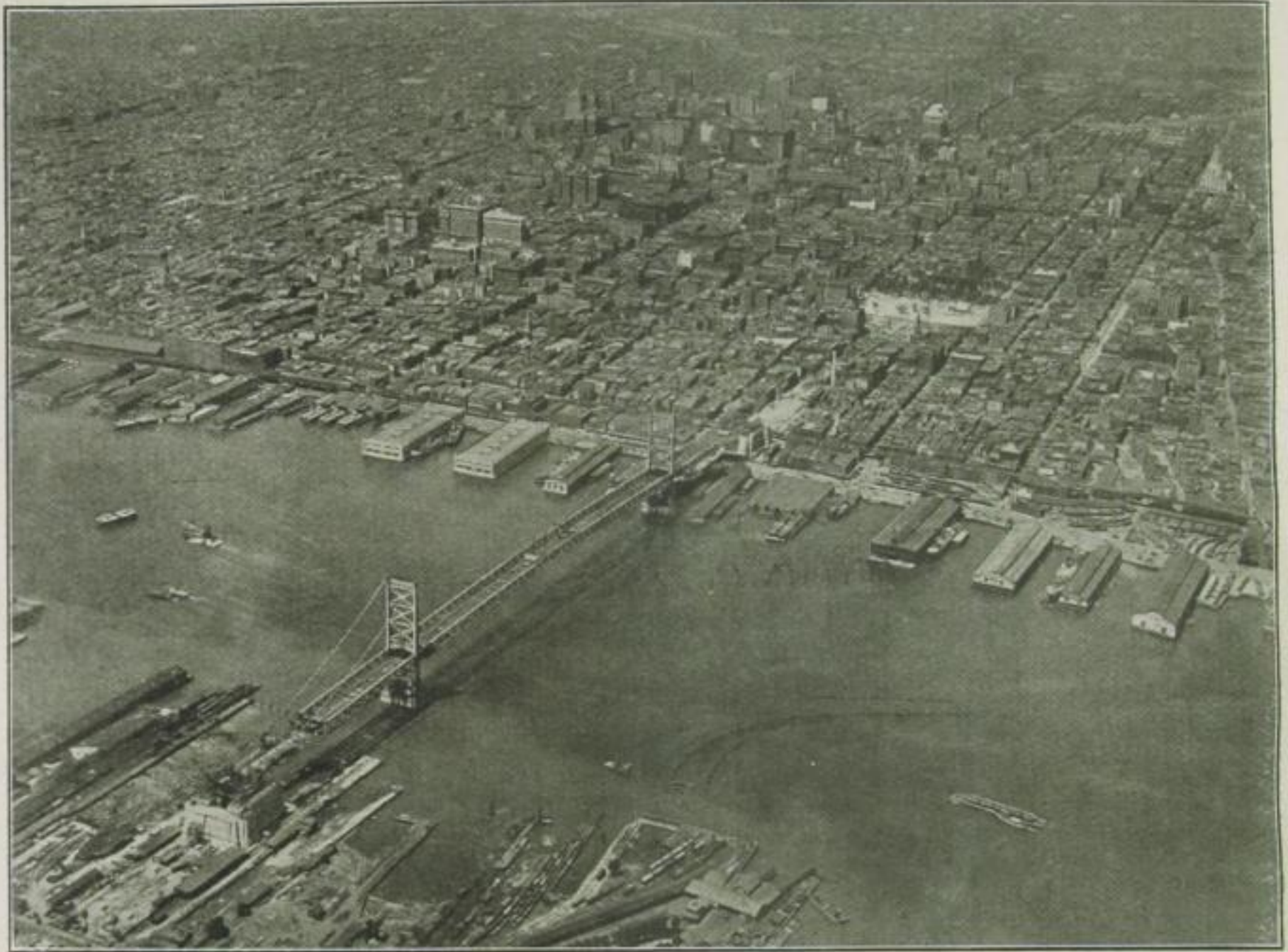
Die Delaware River-Brücke kurz vor der Vollendung
