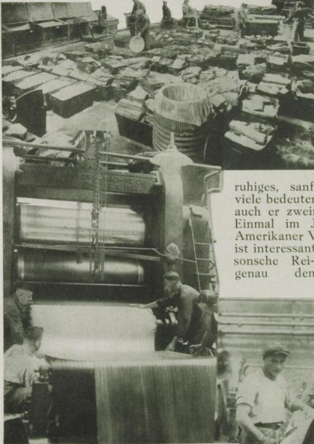
Aufpressen einer zweiten dünnen Gummischicht
