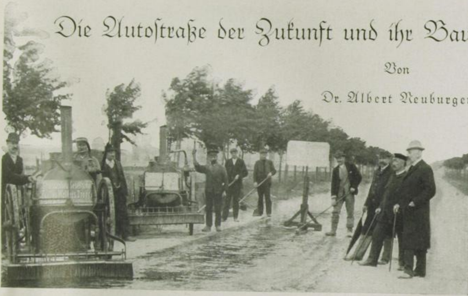
Oberflächenteerung einer Straße mit Hilfe von Teersprengwagen. Der eine Wagen mit gesenktem, der andere mit gehobenem Besen
