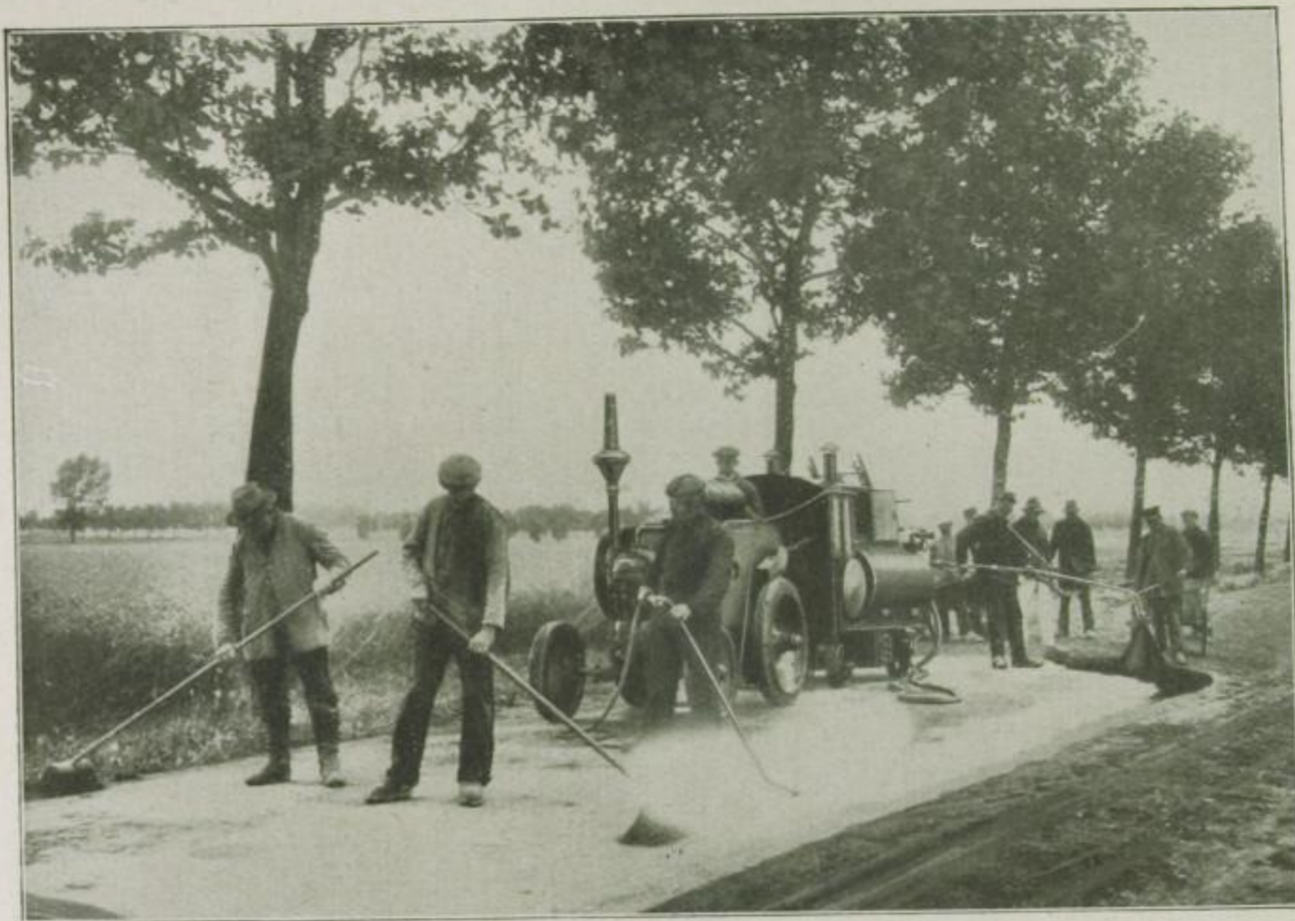
Neuzeitlicher Straßenbau. Selbstfahrende Druckluftanlage zum Kaltasphaltieren von Landstraßen
