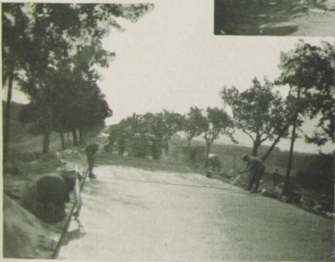
Rhoubenit-Betonstraße. Mischen und Aufbringen des Betons. Im Hintergrund die Mischmaschine
