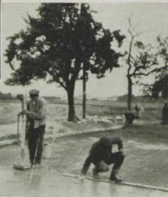
Rhoubenit-Betonstraße. Stampfen des Betons mit Holzstampfen
