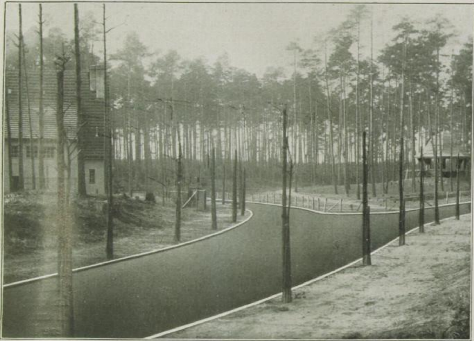
Asphalt-Macadam-Straße in der Villenkolonie Frohnau bei Berlin. Die Straße ist selbst bei starkem Autoverkehr staubfrei
