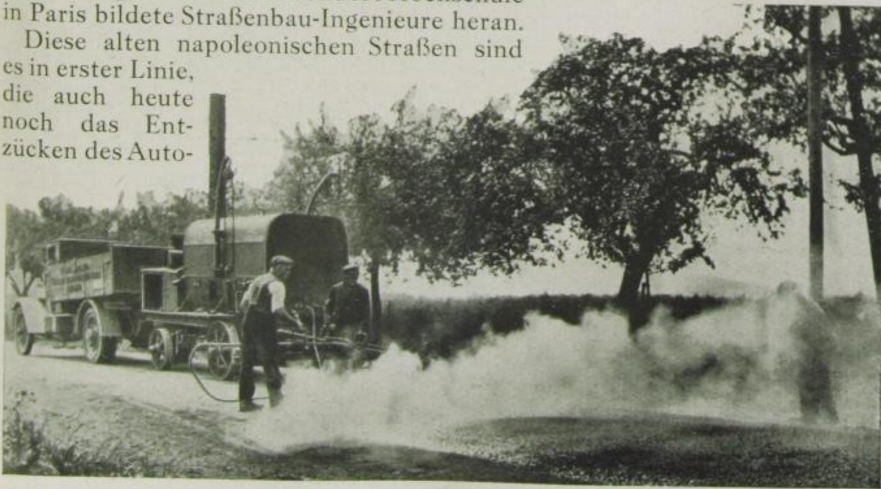
Maschine zum Teeren von Straßen
