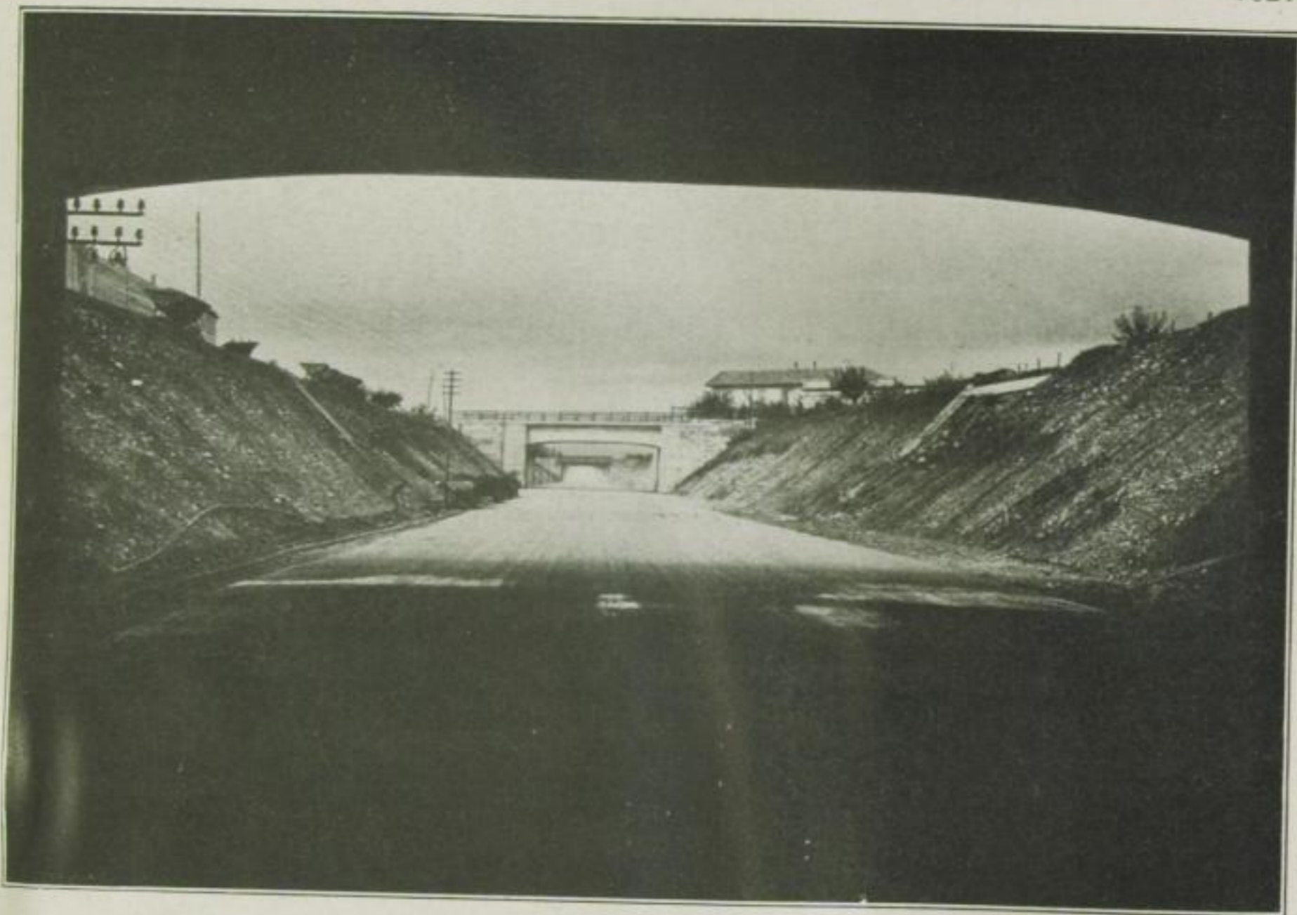
Tunnel de Fernese und Brücken über der Autostraße bei Olgiale Olena
