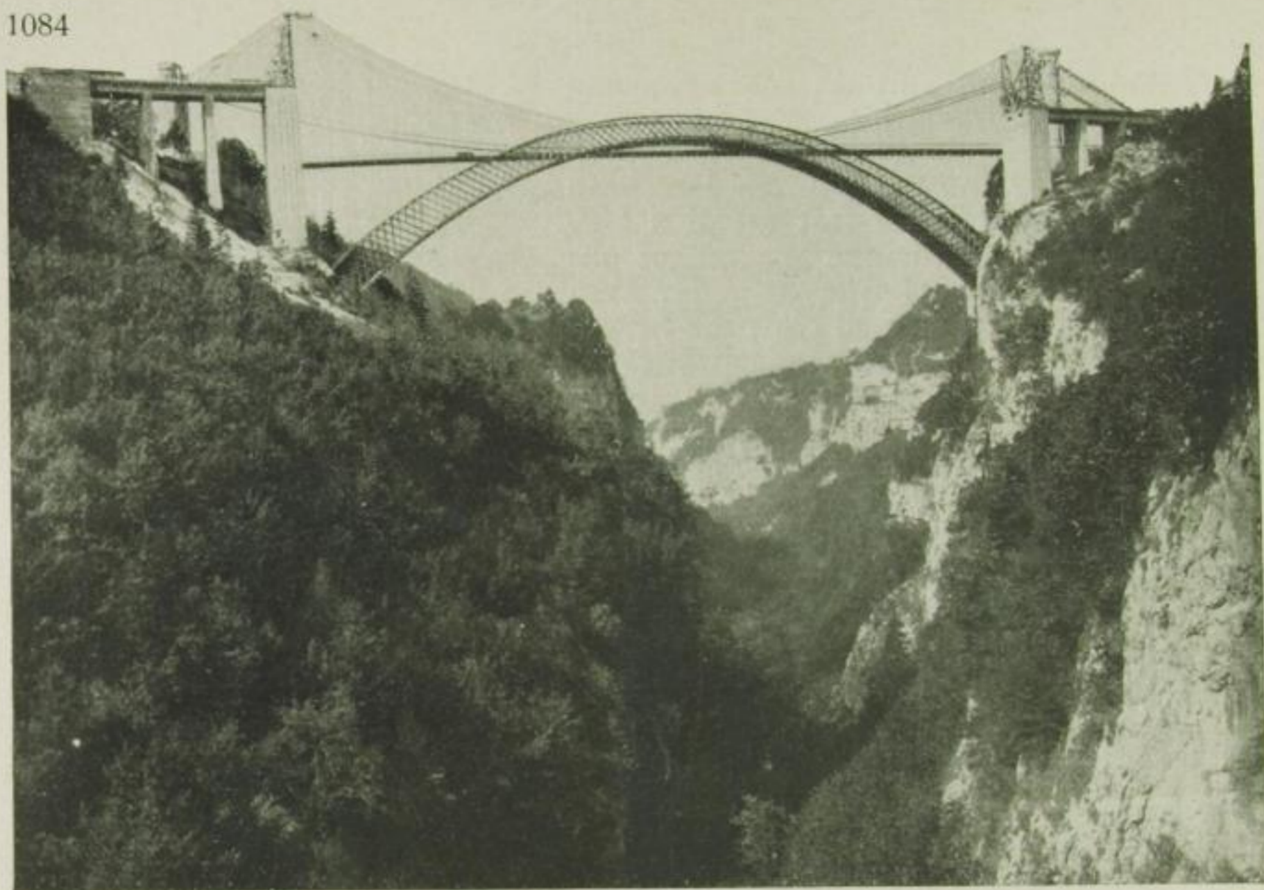
Viadukt de la Caille
