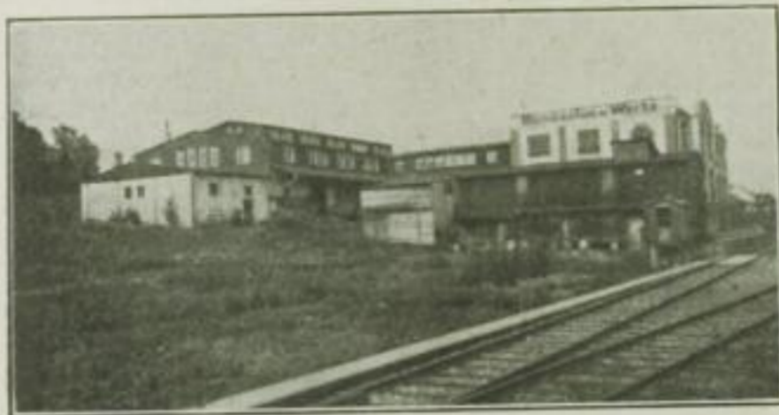
Ansicht vom Fabrik-Anschlußgleis
