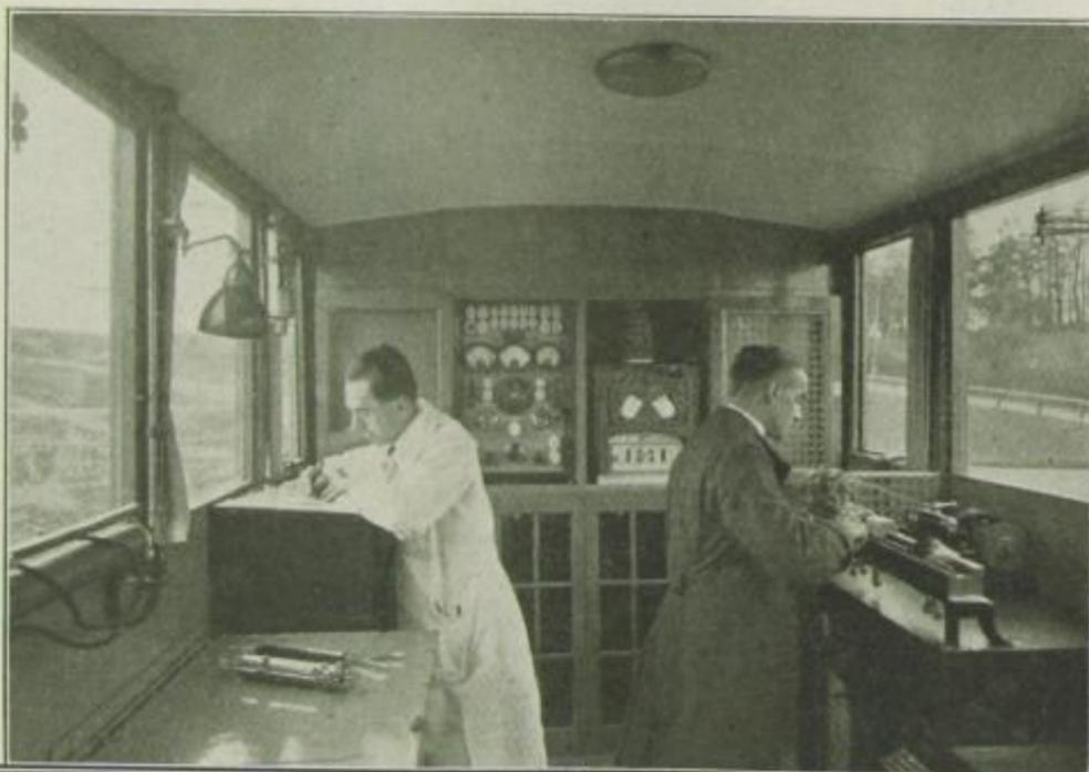
Fahrende Schreibmaschinen-Reparaturanstalt mit Emailierofen, Kupfer- u. Nickelbad
