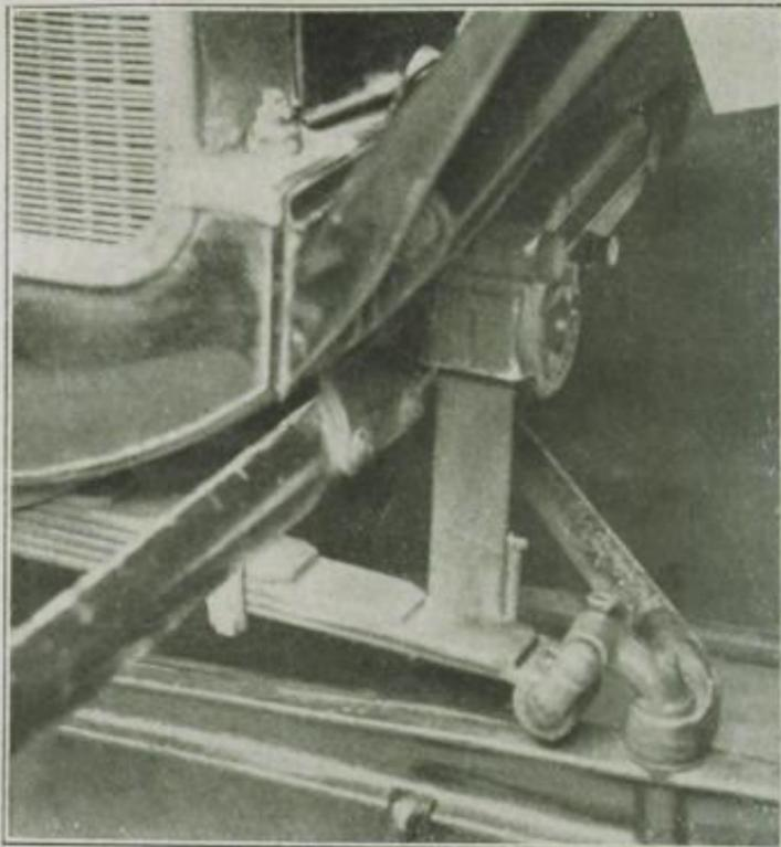
Sonderbauart eines Gurtband-Stoßdämpfers: Weikra-Stoßdämpfer aus einem alten Fordwagen. Hier wird ein Bündel Stahlfedern in das längliche Gehäuse gepreßt (VI)
