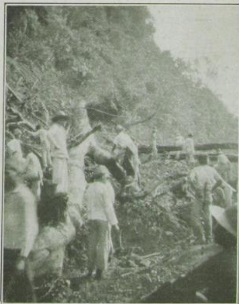
Mühsam muß eine Notstraße gebaut werden
