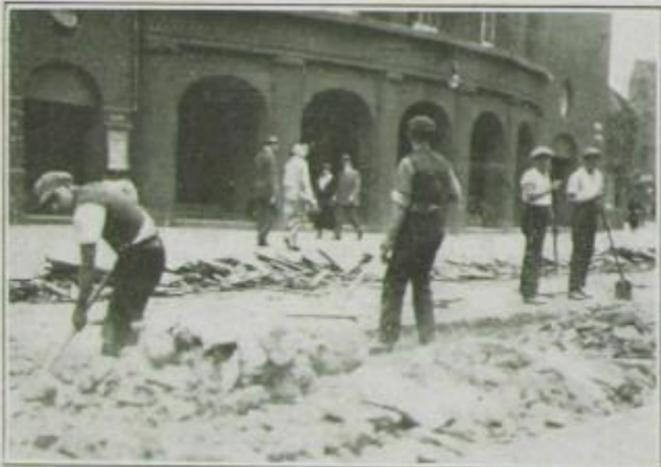
**Ausbesserungsarbeiten der Straßendecke in Deutschland.** Die ganze Straße wird auf einmal bearbeitet. Man arbeitet — ein Fehler im System — auf neuer Fläche weiter, ohne die angefangenen Flächen zunächst fertig zu machen
