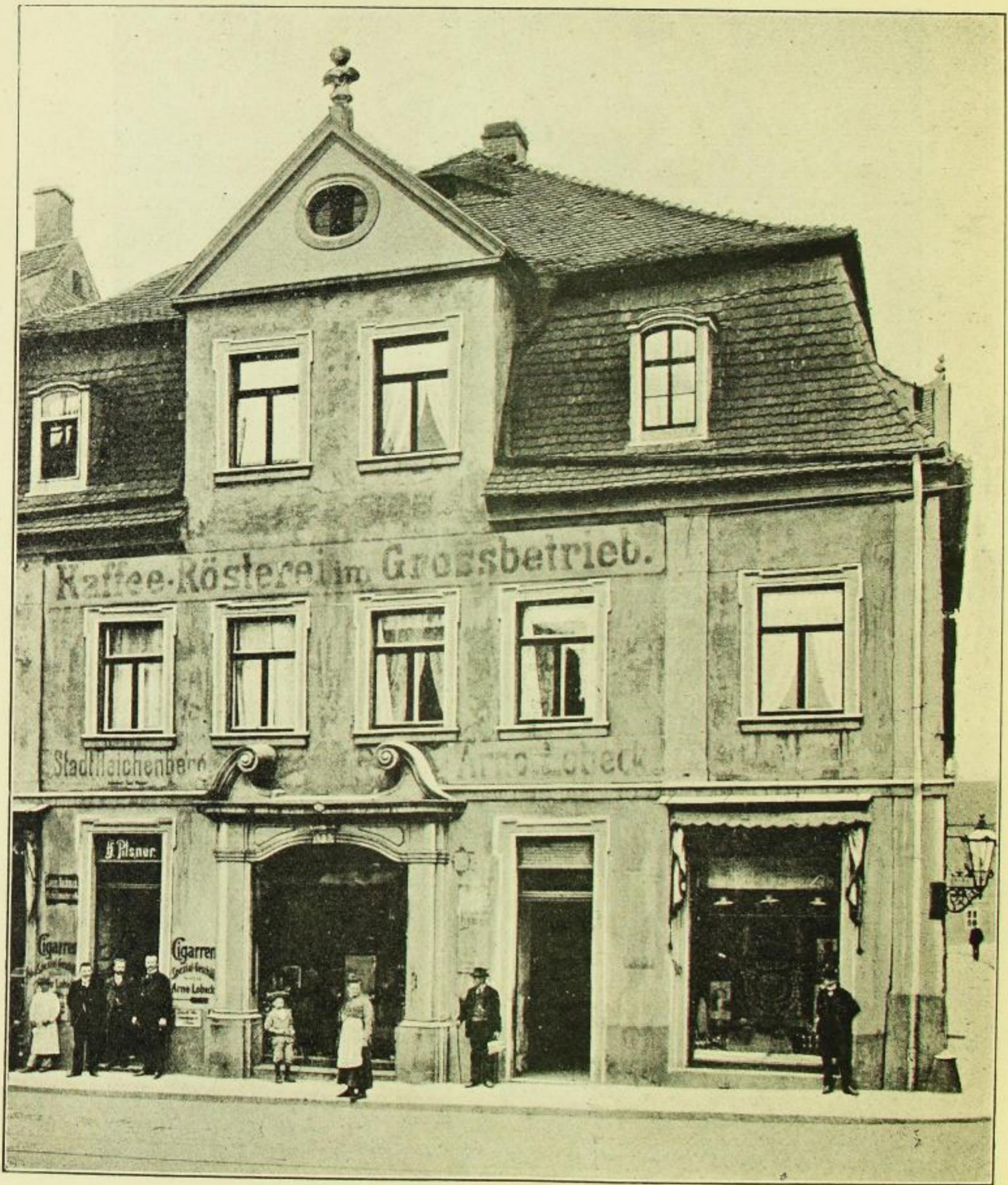
Fig. 265. Reichenberger Straße Nr. 23, Fassade.
