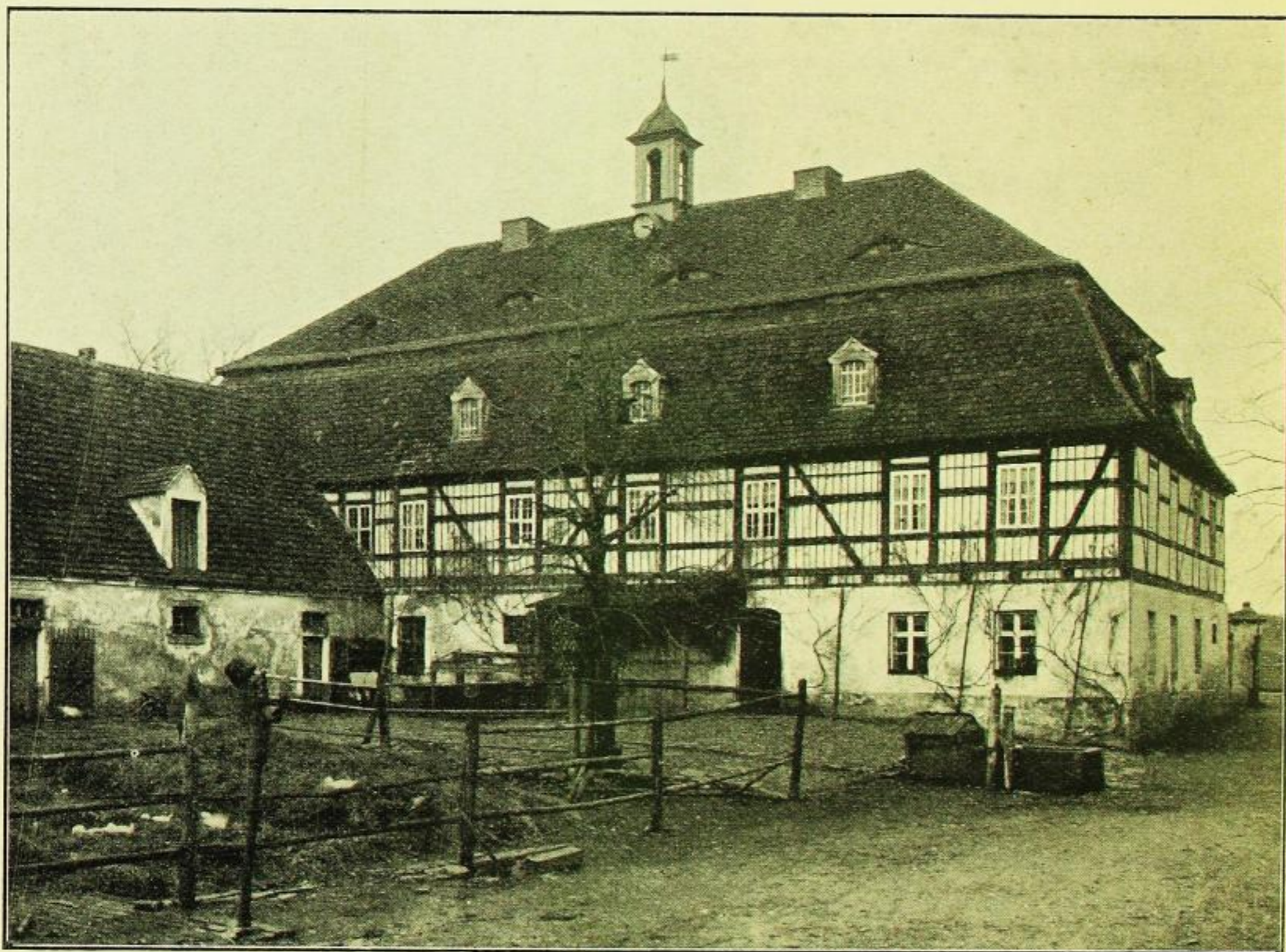
Fig. 319. Röhrsdorf, Rittergut, Pächterwohnhaus.
