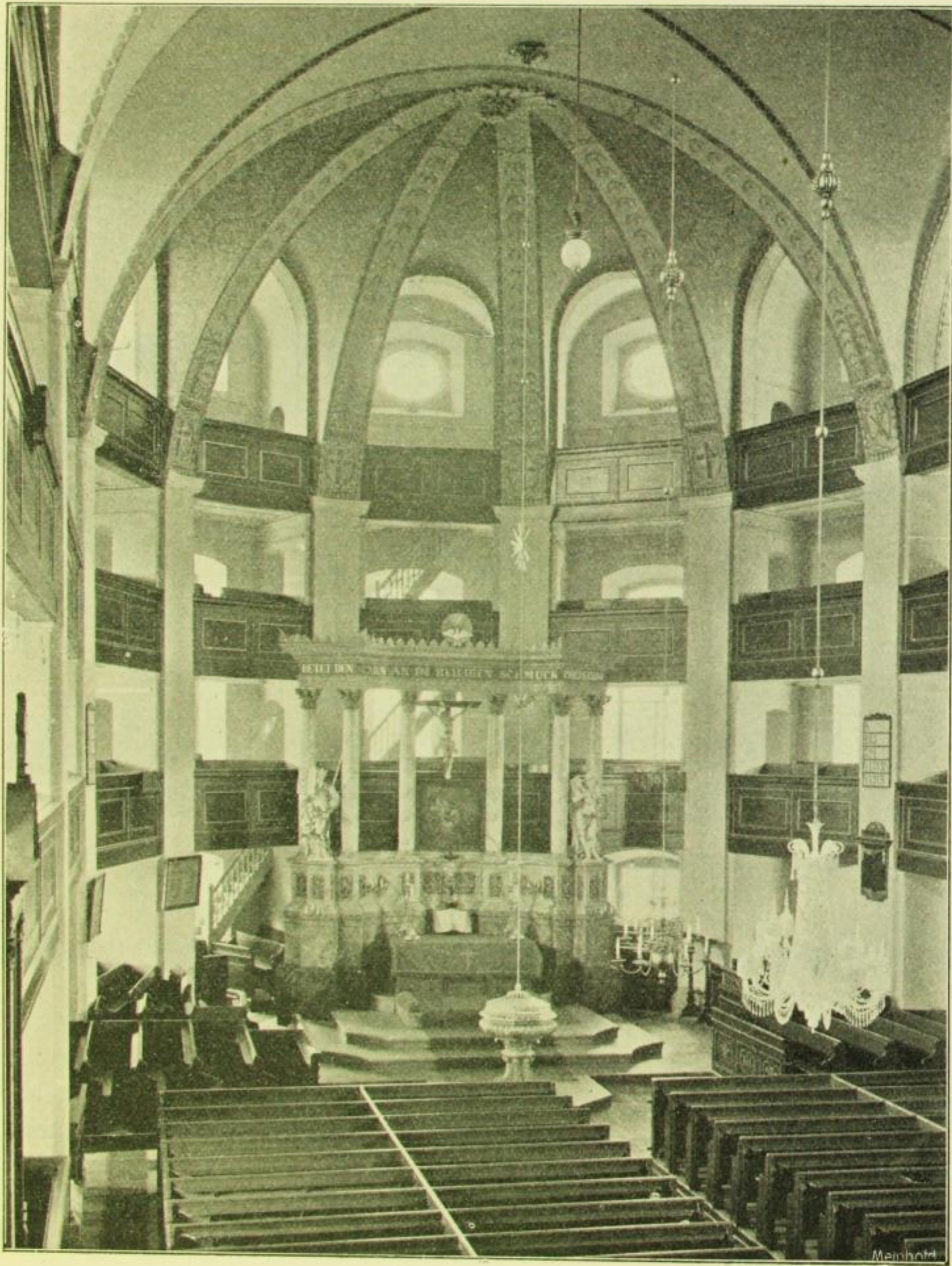
Fig. 116. Eibau, Kirche, Blick in den Chor.
