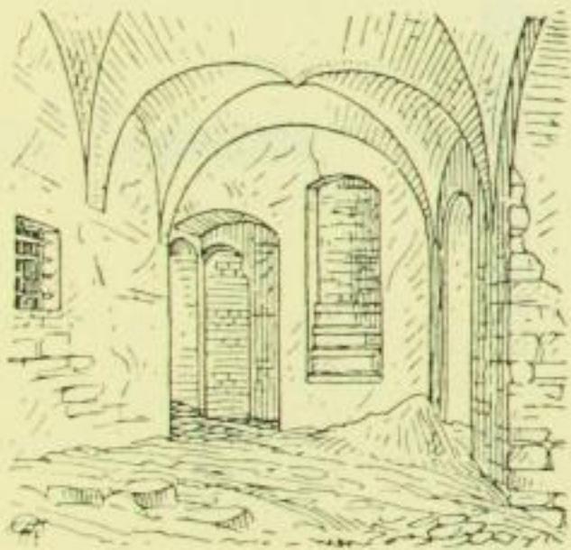
Fig. 145. Großhennersdorf, Schloß, Vermauerte Treppe im Westflügel.
