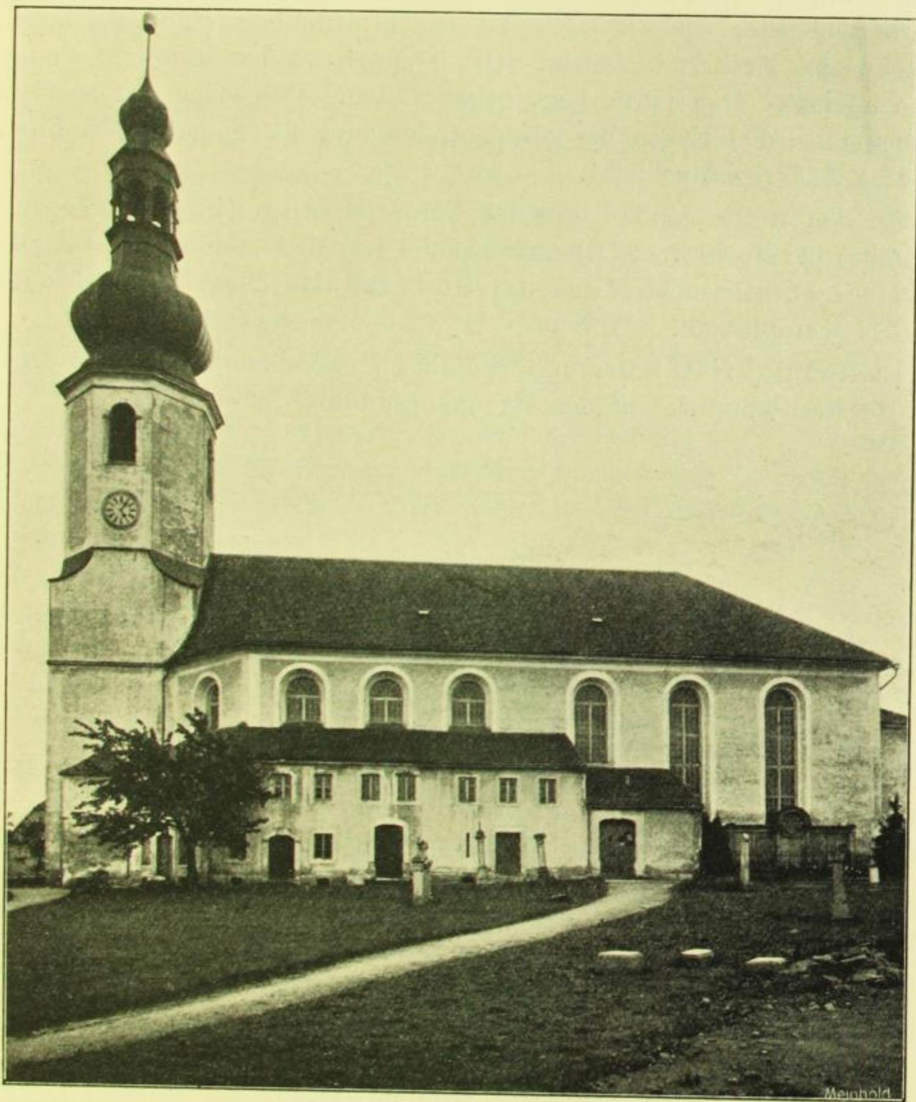
Fig. 200. Hochkirch, Kirche, Nordseite.
