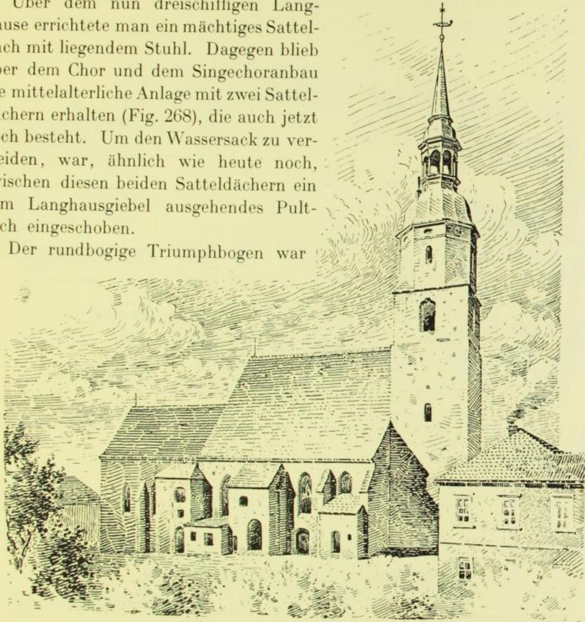
Fig. 262. Löbau, Nikolaikirche, Nordseite, Zustand vor 1884.
