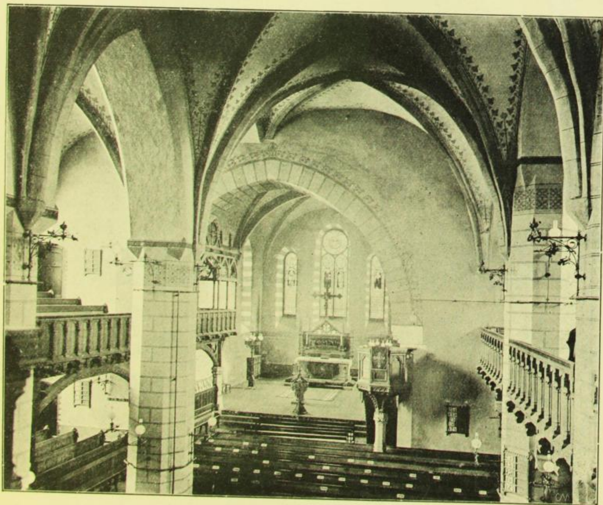
Fig. 272. Löbau, Nikolaikirche, Blick in den Chor.
