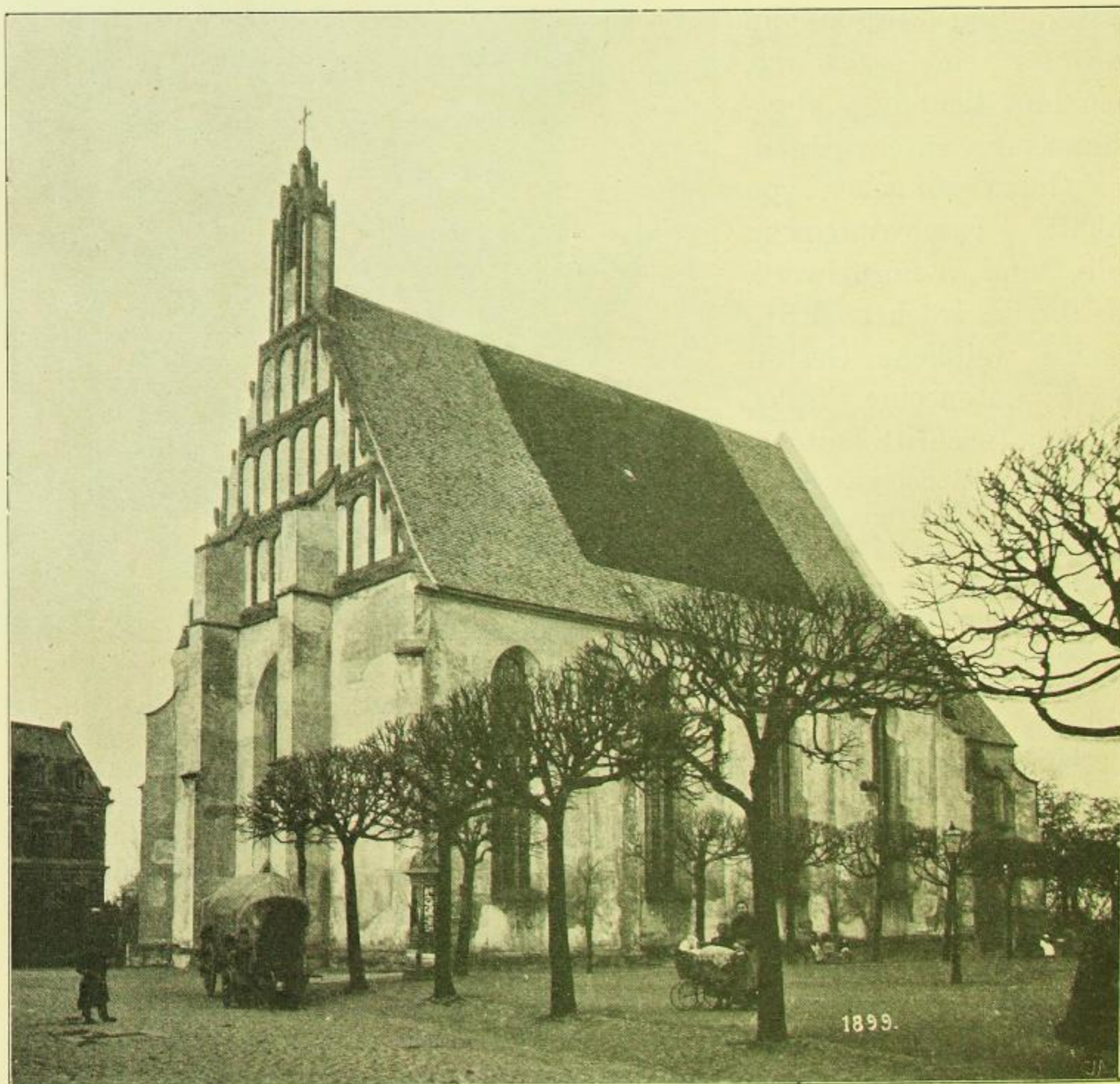
Fig. 175. Klosterkirche, Ansicht von Südwest.
