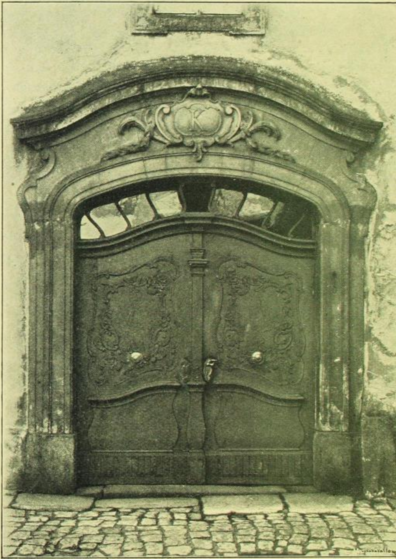
Fig. 355. Lange Straße Nr. 4. Tor.
