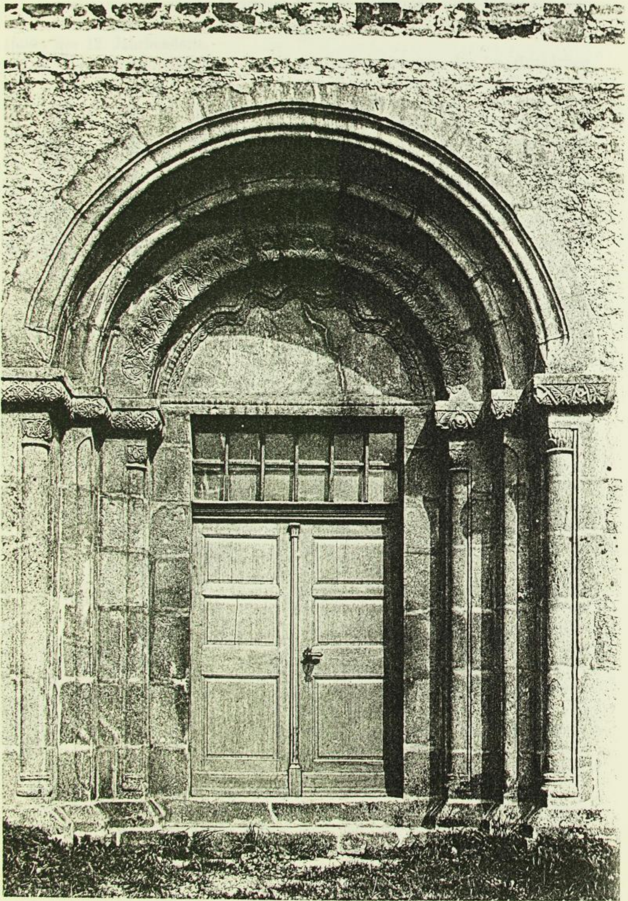
Geithain, St. Nikolaikirche: Westpforte.
