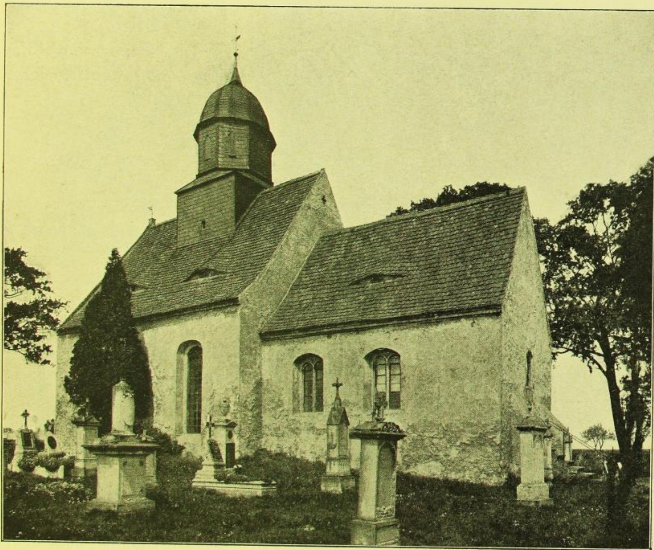
Fig. 447. Steinbach, Kirche, Ansicht von Südosten.
