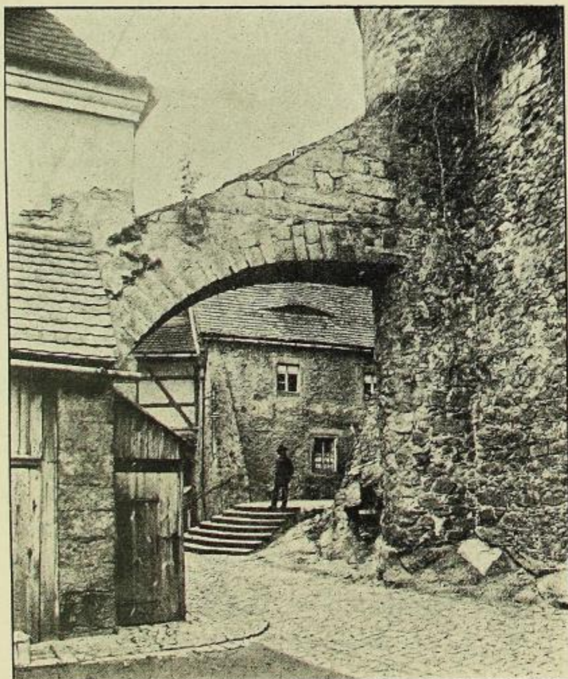
Fig. 206. Radeberg, Strebepfeiler im Hof.
