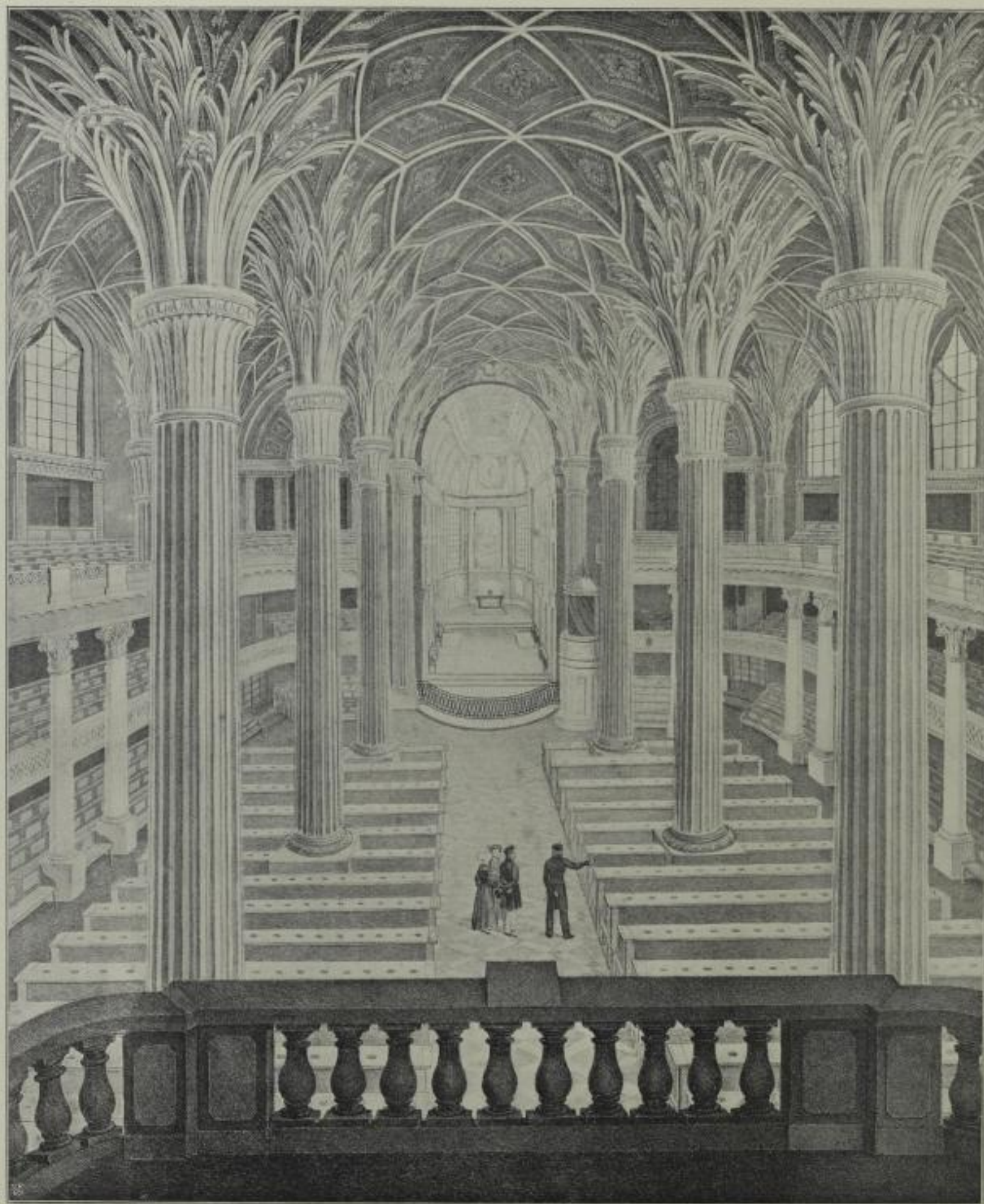
Das Innere der Nikolaikirche nach dem Umbau. 1797.
