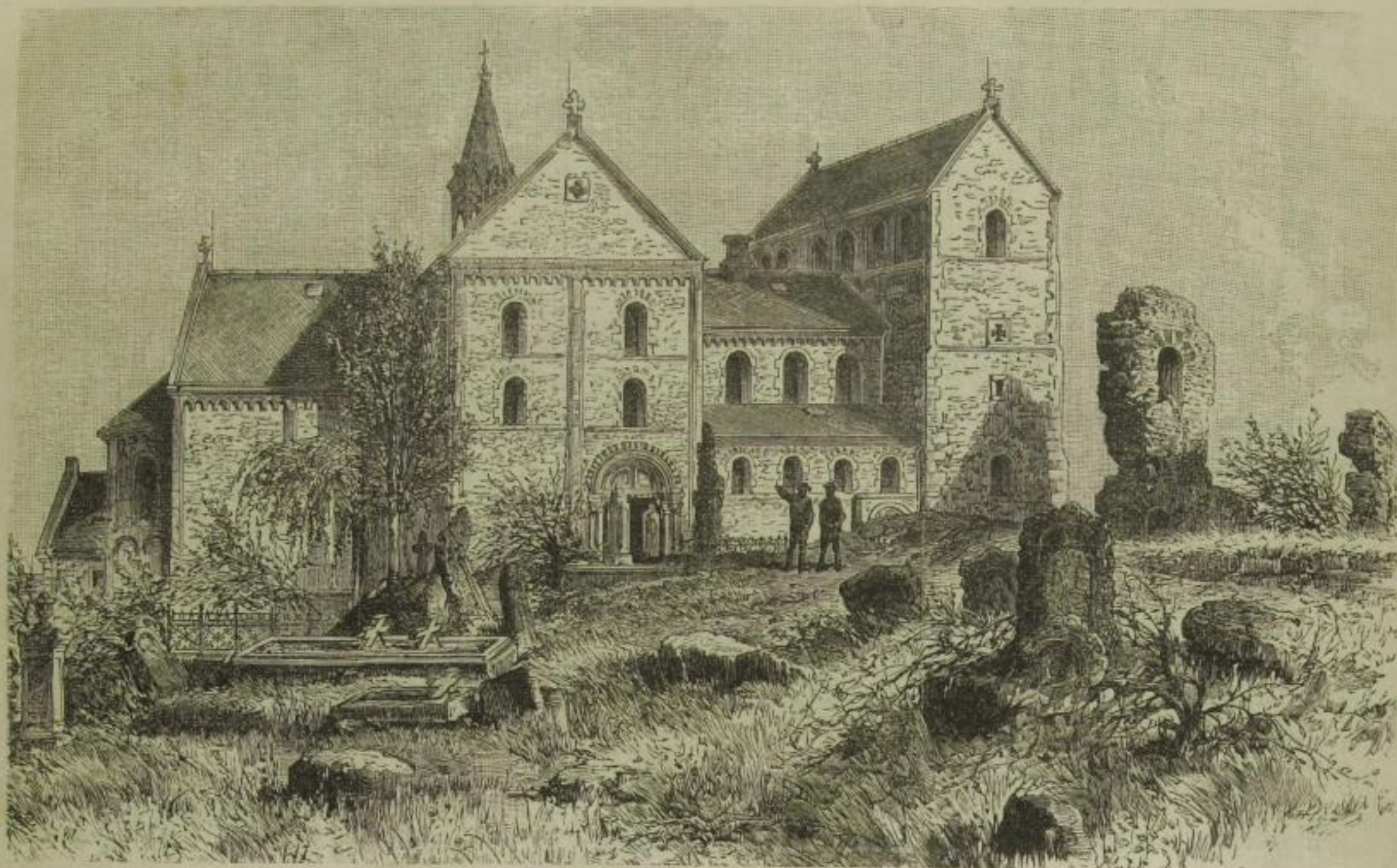
Die Peterskirche auf dem Petersberge bei Halle.
