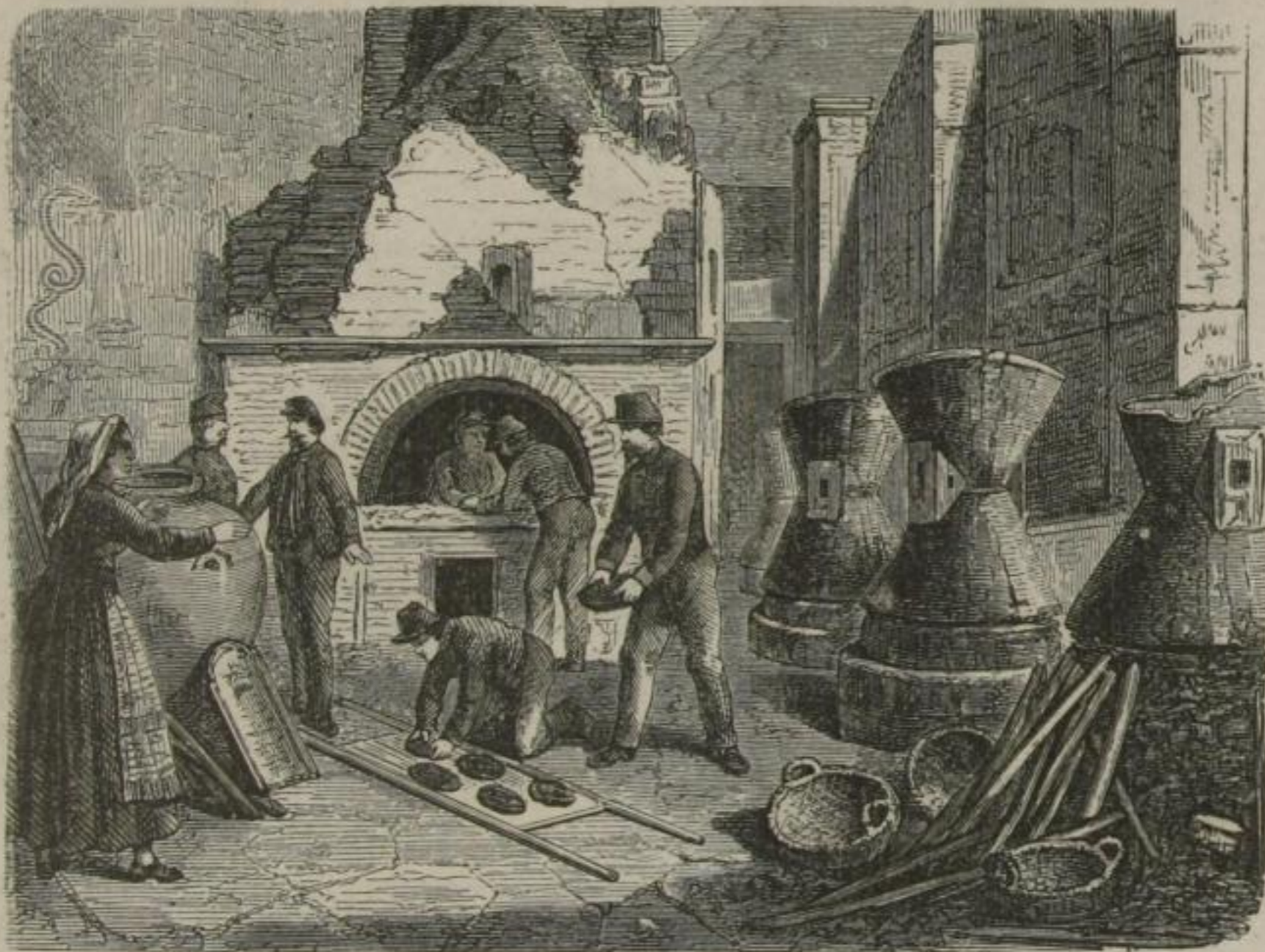
Fig. 5. Ausgrabung einer Bäckerei in Pompeji.
