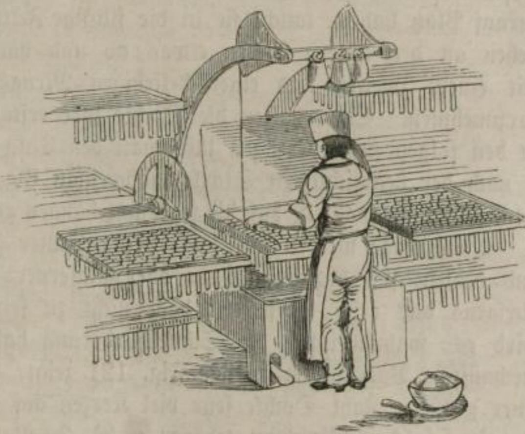
Fig. 121. Rahmen zum Lichterziehen.
